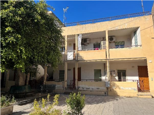
Prospetto principale "vista 1"
