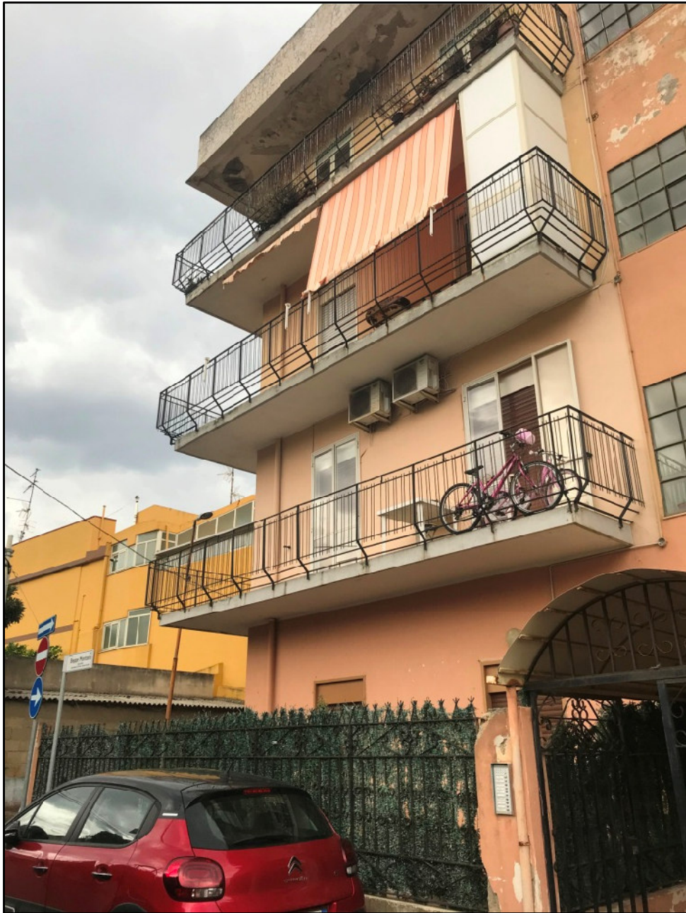
Foto 1 – Inquadratura frontale del fabbricato.
