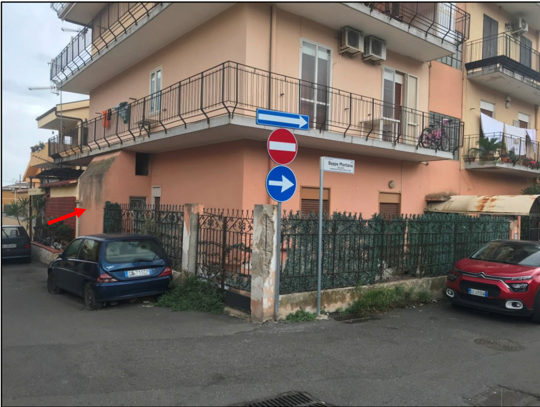
Foto 2 – Inquadratura della veranda al piano terra, estesa sui due lati della casa. Indicata dalla freccia, è visibile la parte in ampliamento realizzata in abuso, per la quale si rende necessaria la demolizione.
