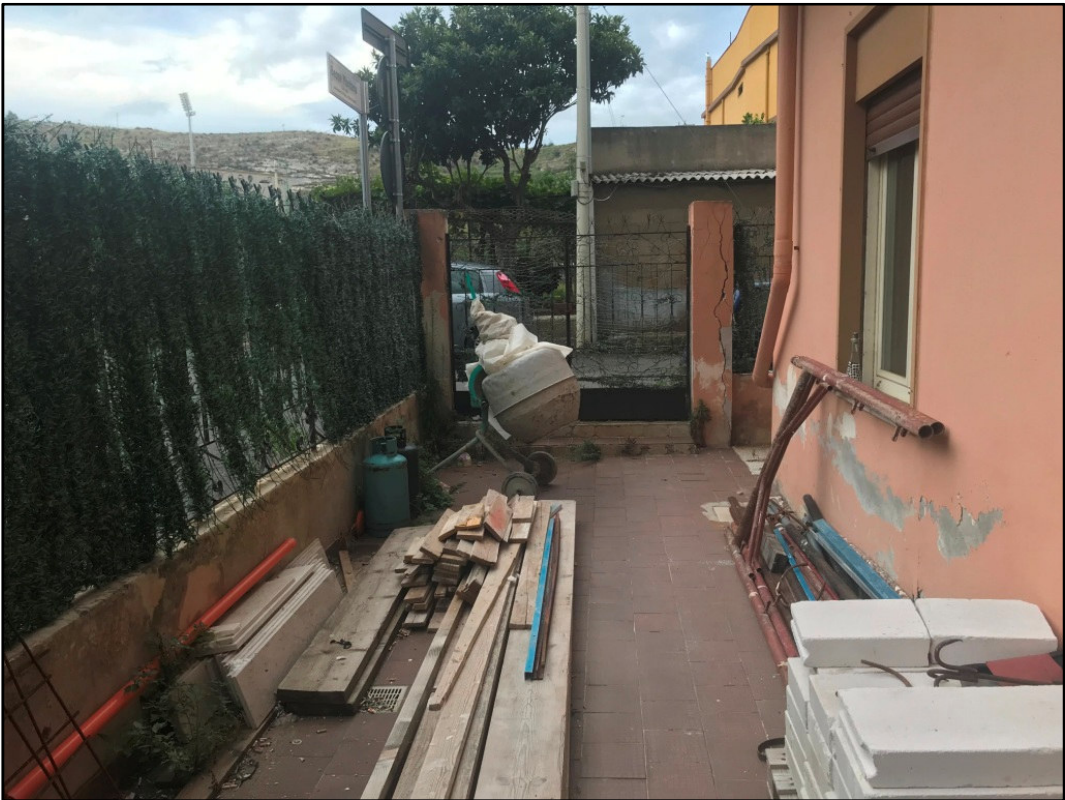
Foto 5 – Inquadratura della parte di veranda lato nord.
