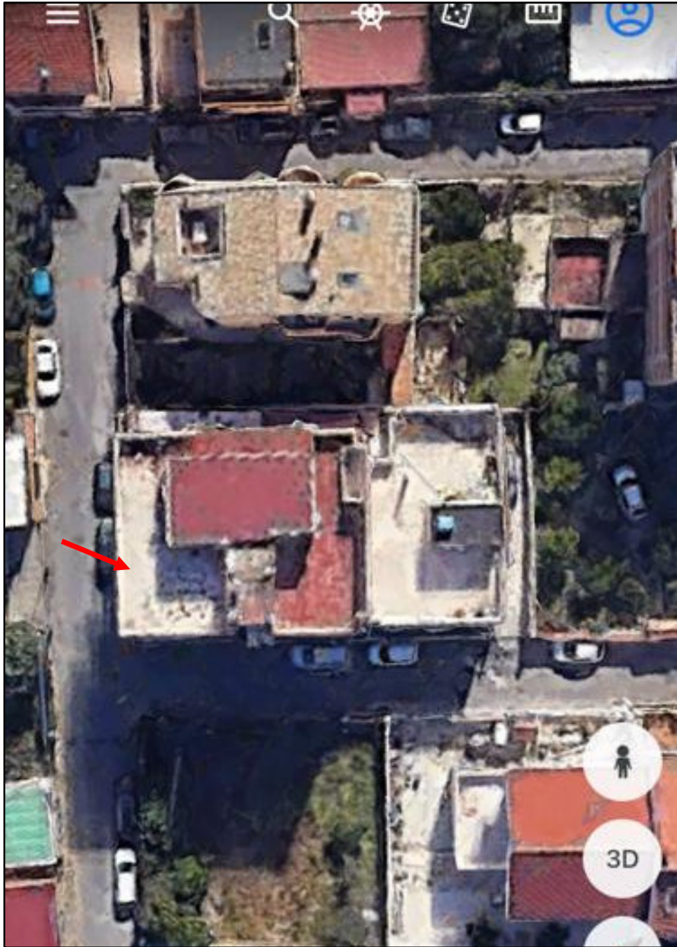
Foto 12 – Inquadratura dall'alto, del lastrico solare del fabbricato (da Google Maps). Indicato dalla freccia, è visibile la porzione di pertinenza all'immobile oggetto di stima (sub. 12)
