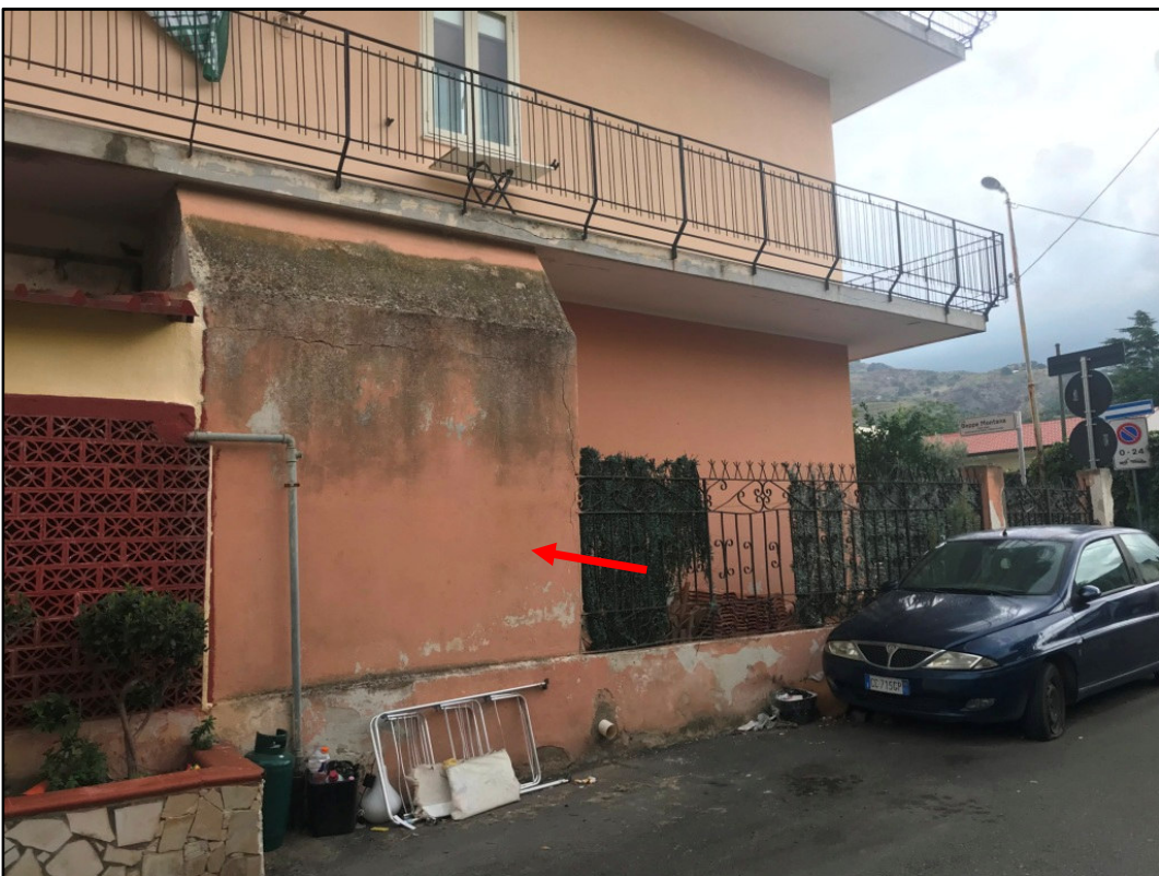
Foto 3 – Inquadratura dal lato est, con indicata la parte edificata in abuso, da demolire.
