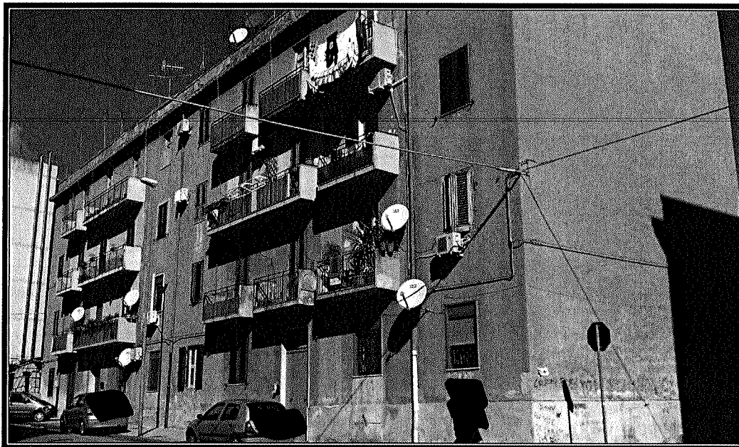
Vista corpo di fabbrica
