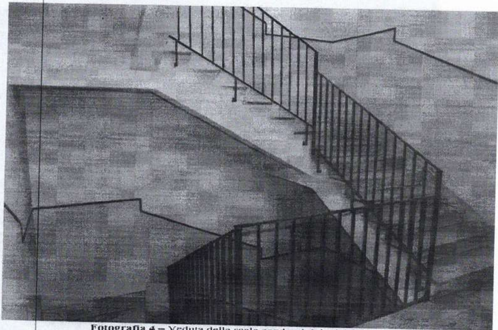
Fotografia 4 – Veduta della scala condominiale del fabbricato.
