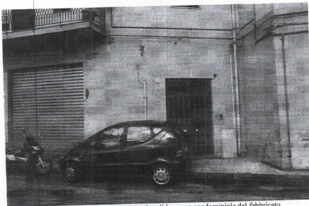
Fotografia 2 – Veduta del portoncino di ingresso condominiale del fabbricato.
