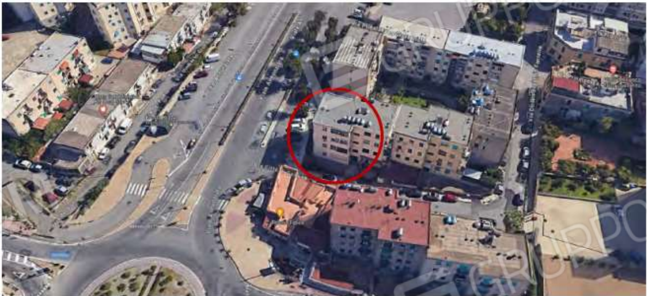
FOTO 4 - FOTO AEREA DA OVEST
