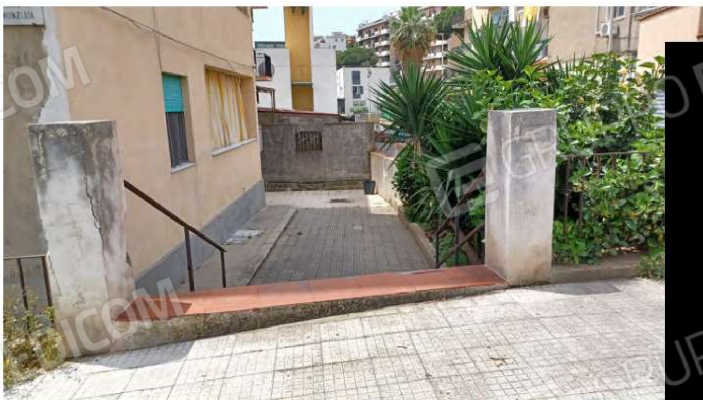
FOTO 6 – INGRESSO AREA CONDOMINIALE SU VIALE ANNUNZIATA
