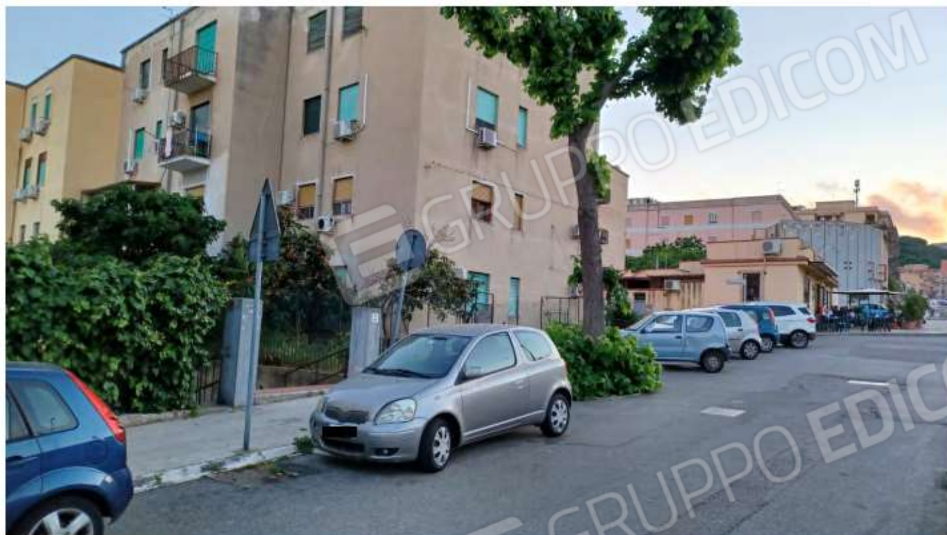
FOTO 5 – PROSPETTO DAL CONTROVIALE DEL VIALE ANNUNZIATA
