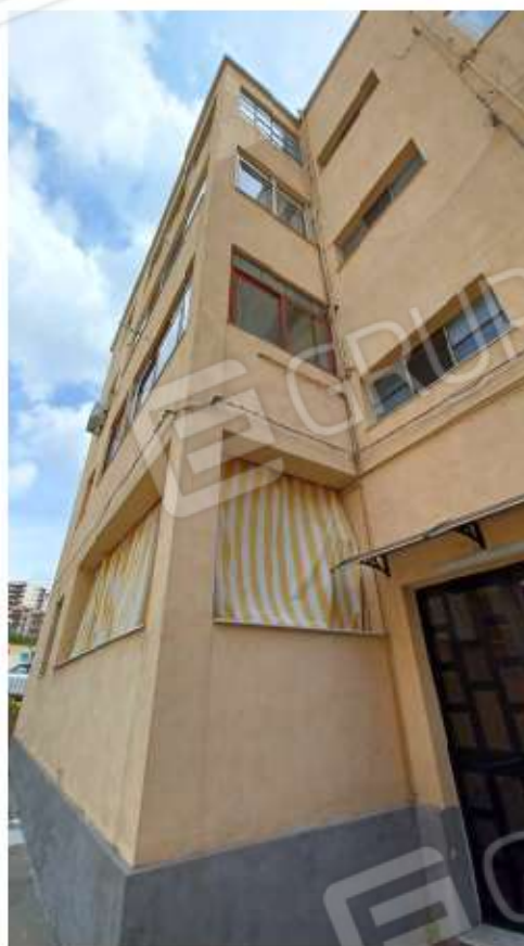
FOTO 9 VISTA VERANDE DA AREA INGRESSO
