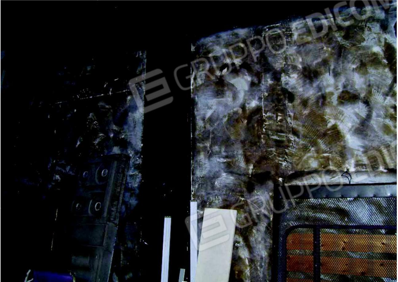
**FOTO N.23 RIVESTIMENTO PANNELLI ISOLANTI PARETI PIANO TERRA**
