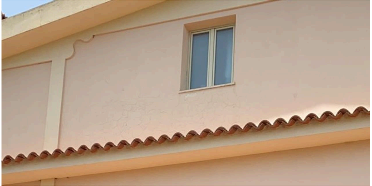
Particolare della facciata ex
