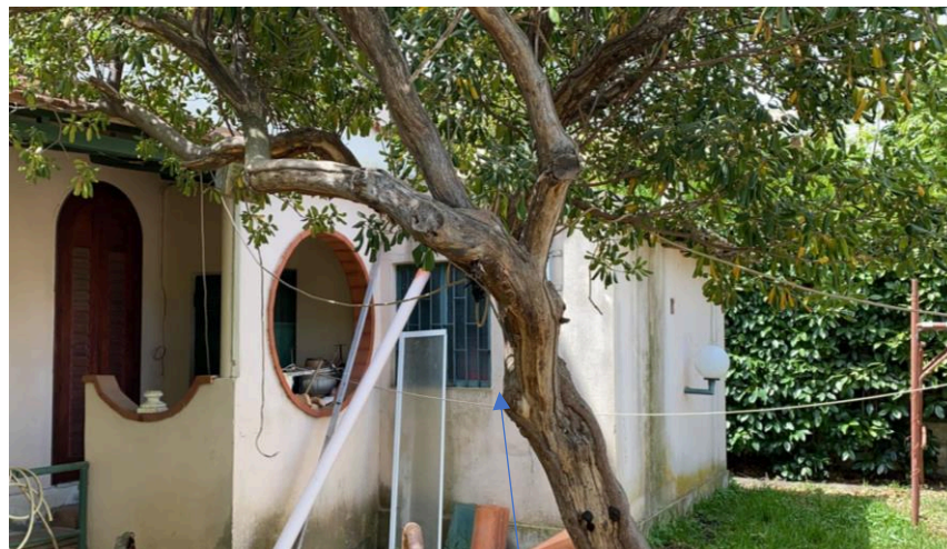
Particolari del piano terra – da restaurare
