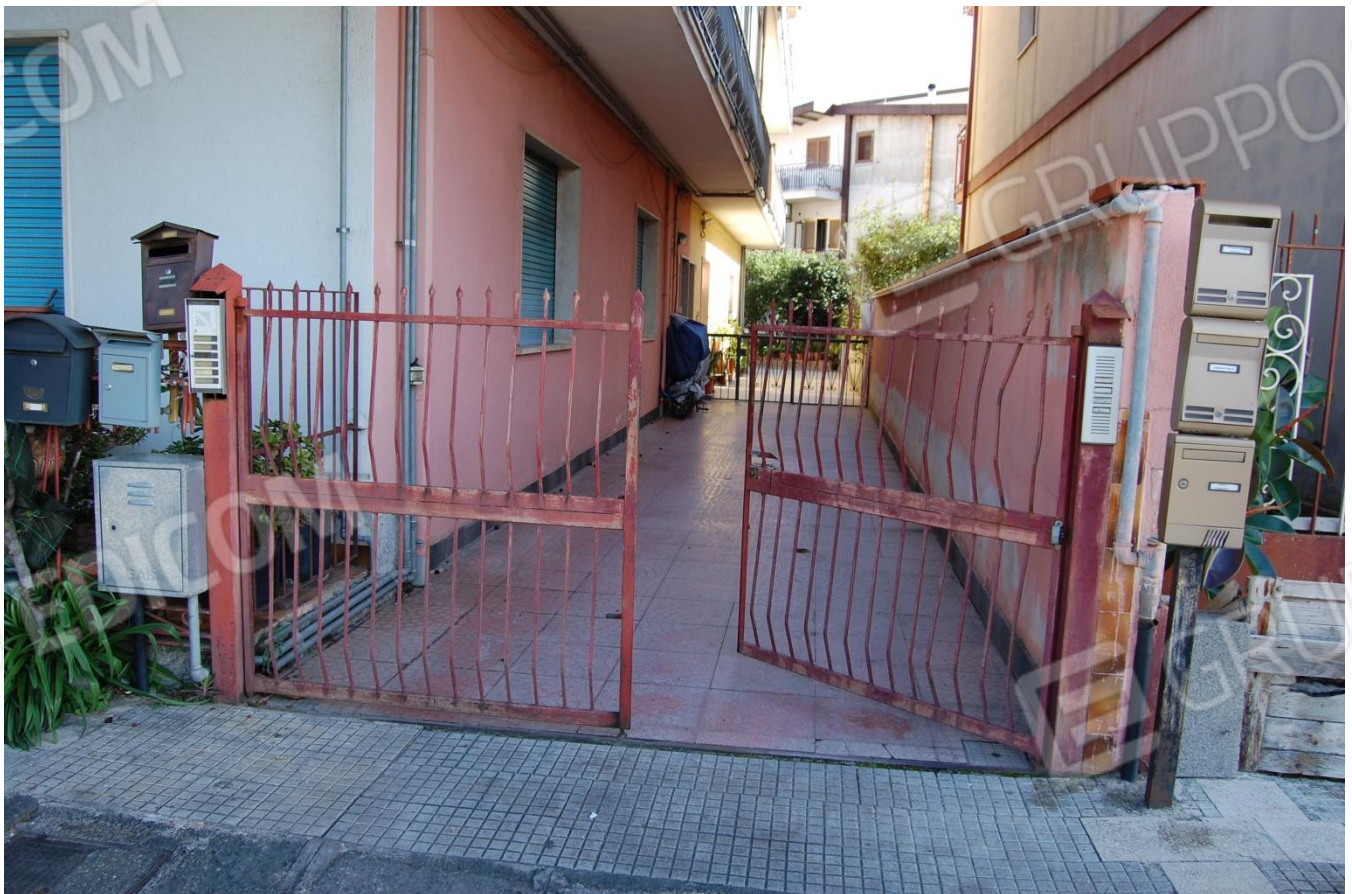
FOTO 6: cancello di accesso al cortile interno
