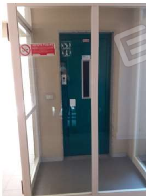
Foto nr. 2 : particolare del corpo ascensore
