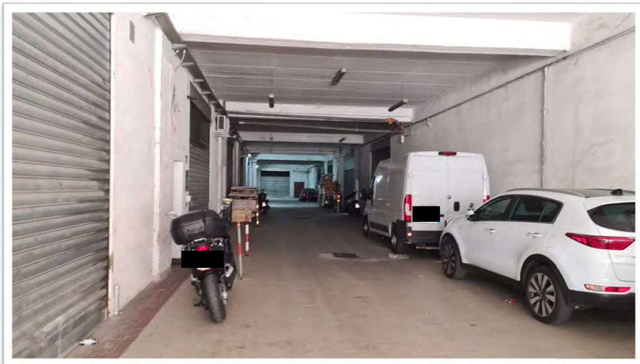
Vista dell'ingresso ai depositi ubicati al piano cantinato
