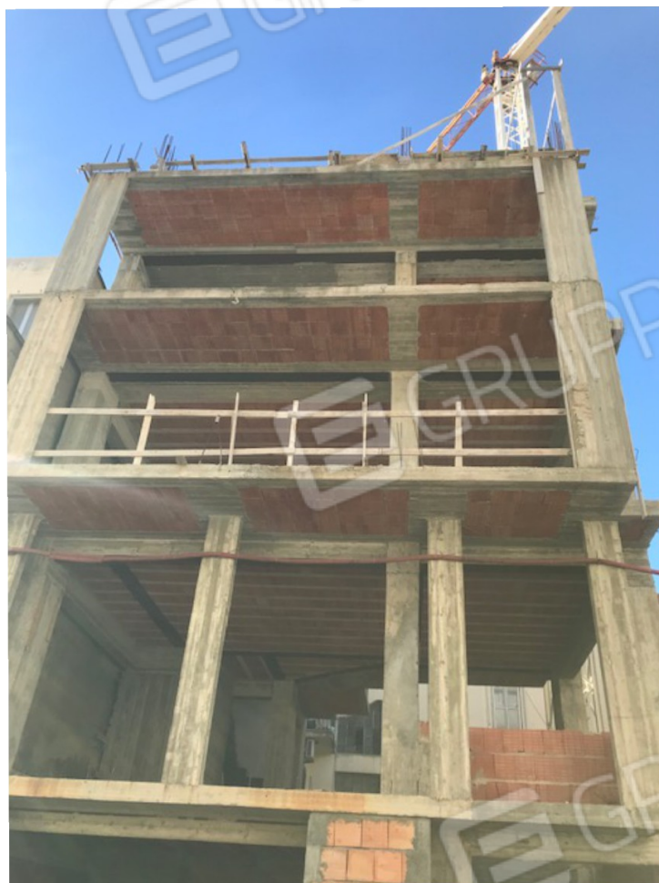
Foto 1 => l'edificio in cemento armato ad oggi realizzato (prospetto su via Freri). Complessivamente realizzati al rustico 4 piani : PT, piano in deroga, primo e secondo piano.
