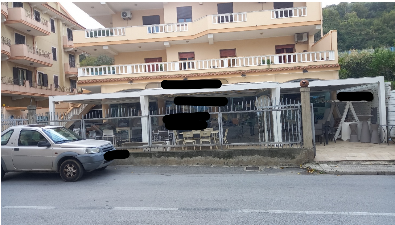
Foto nr. 1: prospetto lato strada statale
