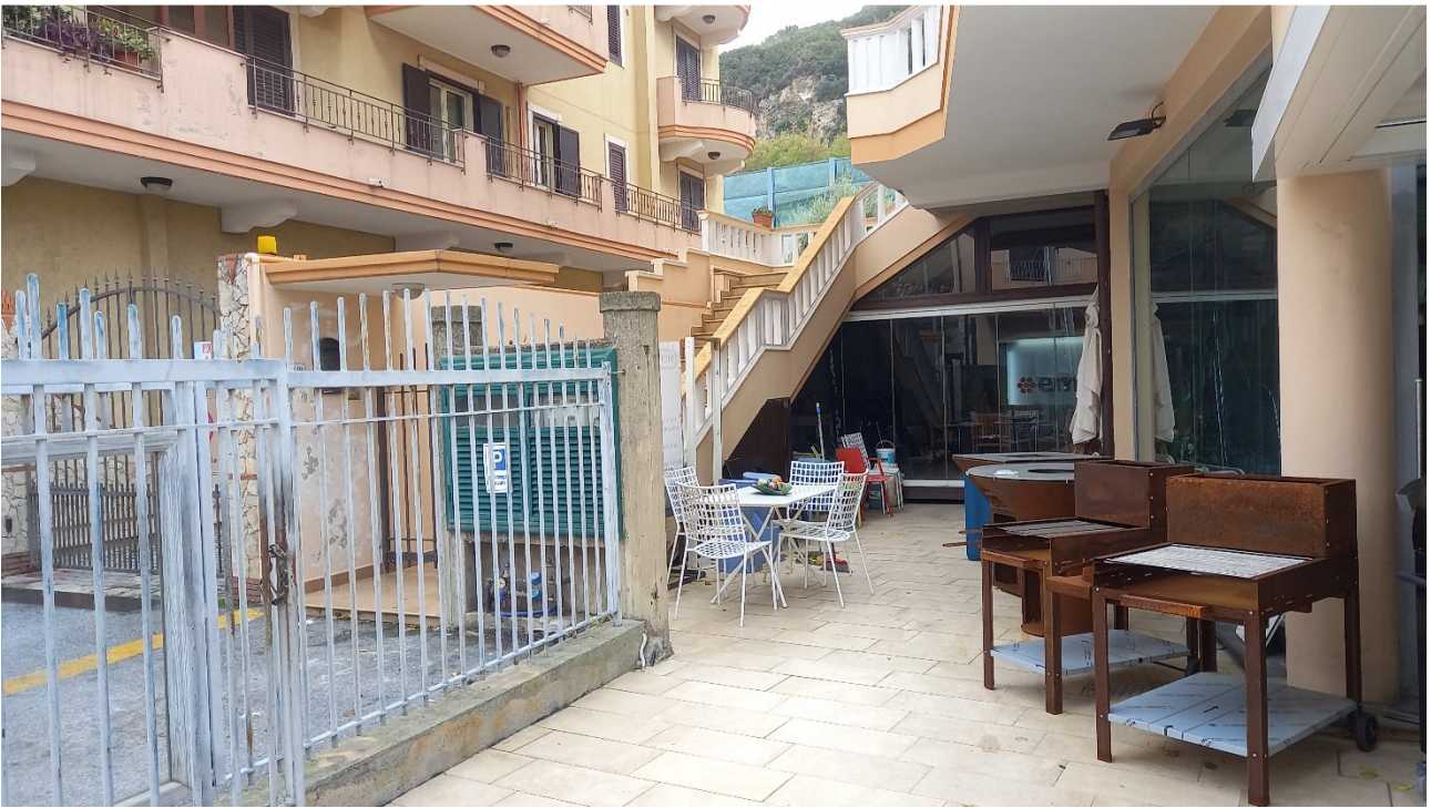
Foto nr. 3: spazio esterno, progettualmente destinato a viabilità
