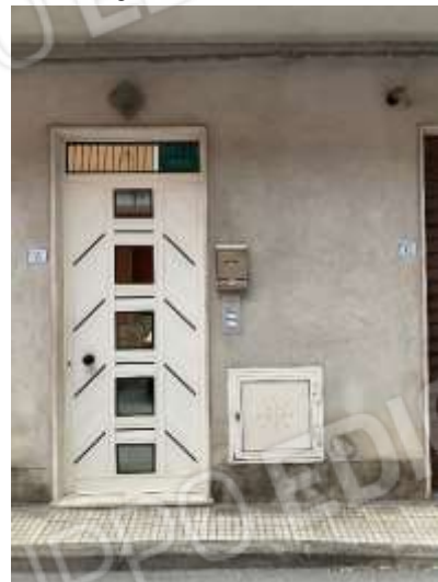
Foto 3 “Ingresso all’unità immobiliare”
