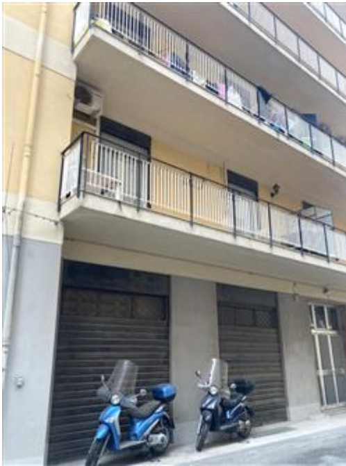
foto n. 01 - vista del fabbricato e del balcone di pertinenza dell'immobile
