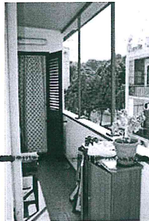
Ampliamento del vano su balcone
