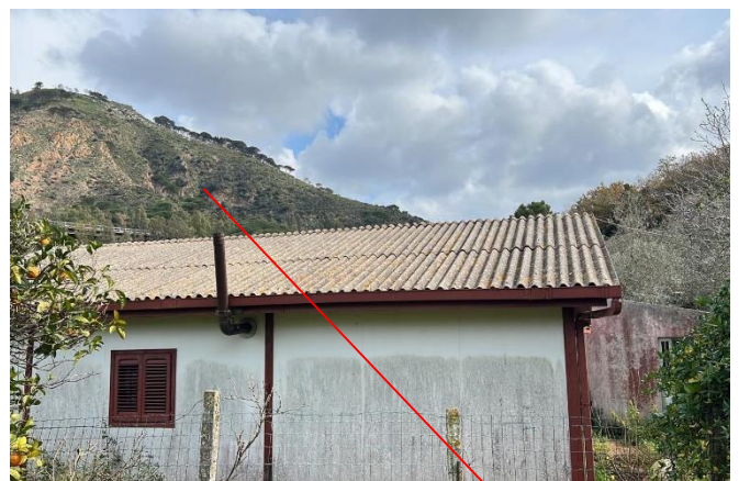
Prospetto laterale (sullo sfondo terreno part. 79)
