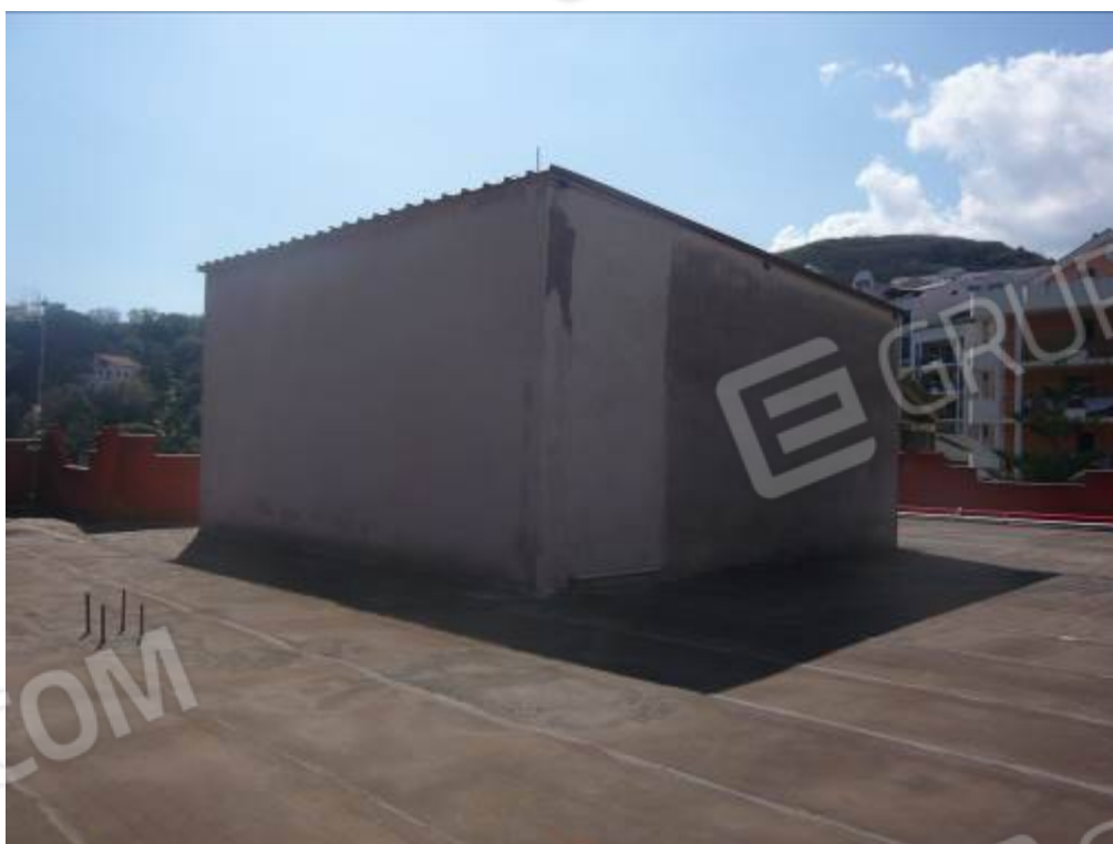
FOTO 49 – LASTRICO SOLARE CON LOCALE DEPOSITO
