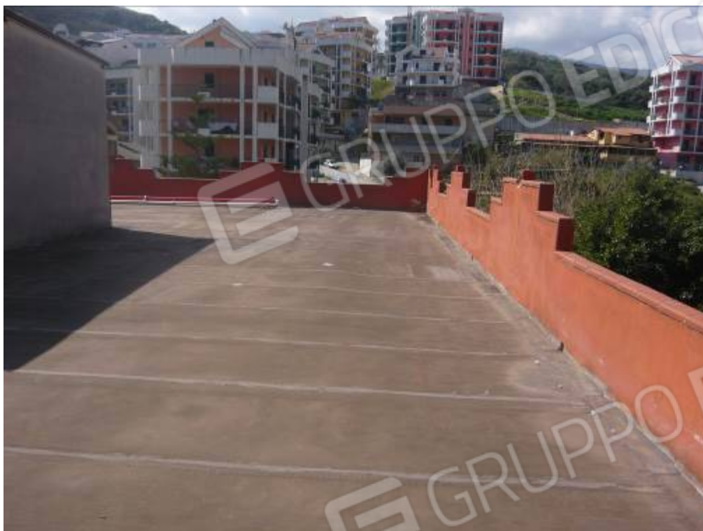
FOTO 48 – LASTRICO SOLARE CON LOCALE DEPOSITO
