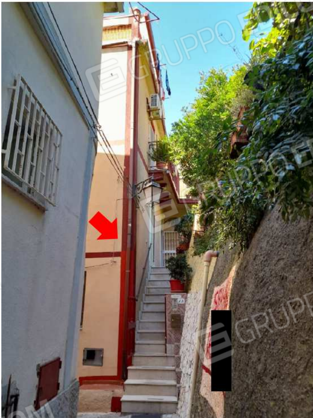
-Foto n.3: Immobile oggetto di causa-
