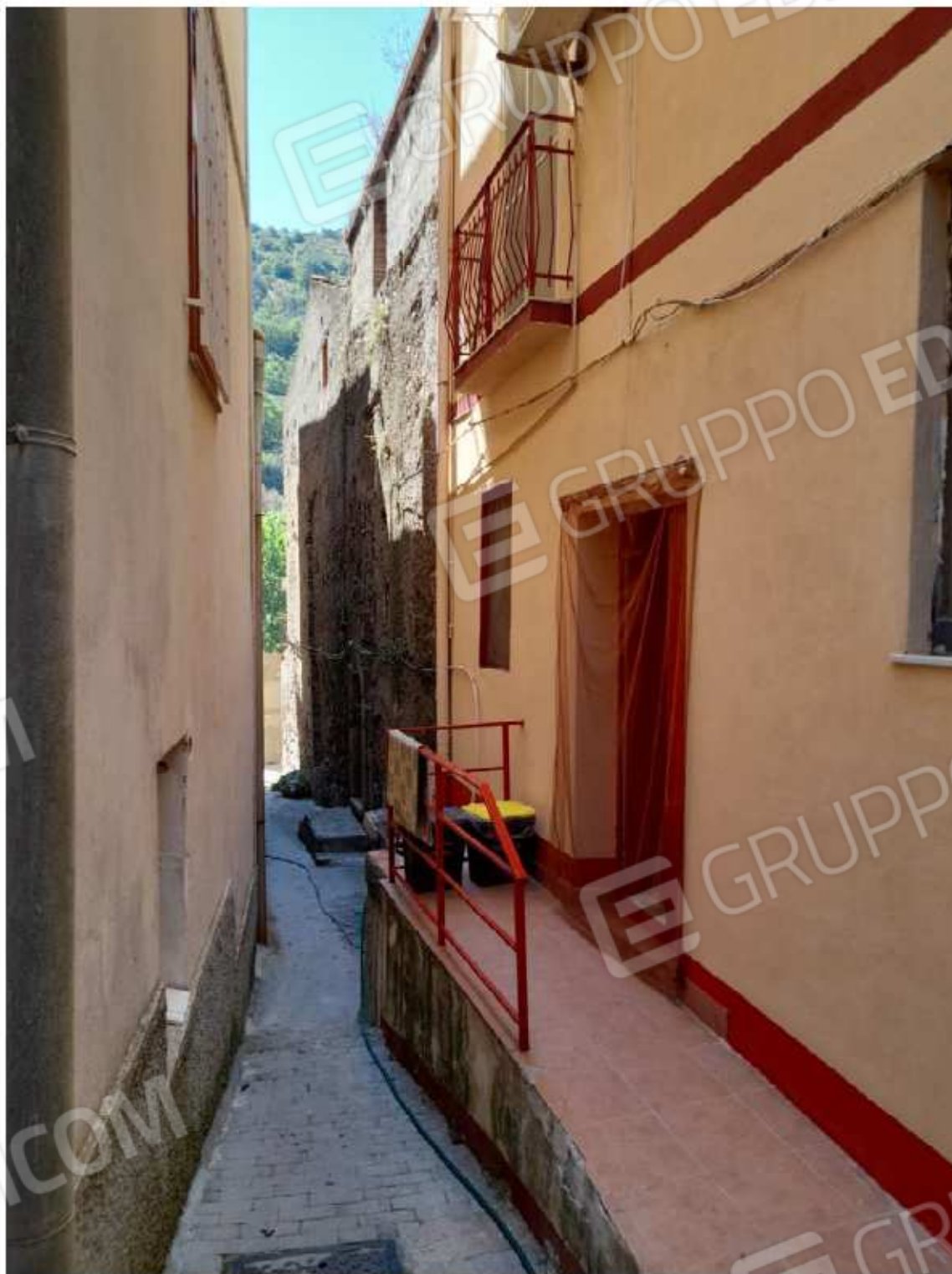
-Foto n.5: Immobile oggetto di causa, prospetto lato Nord Ovest-
