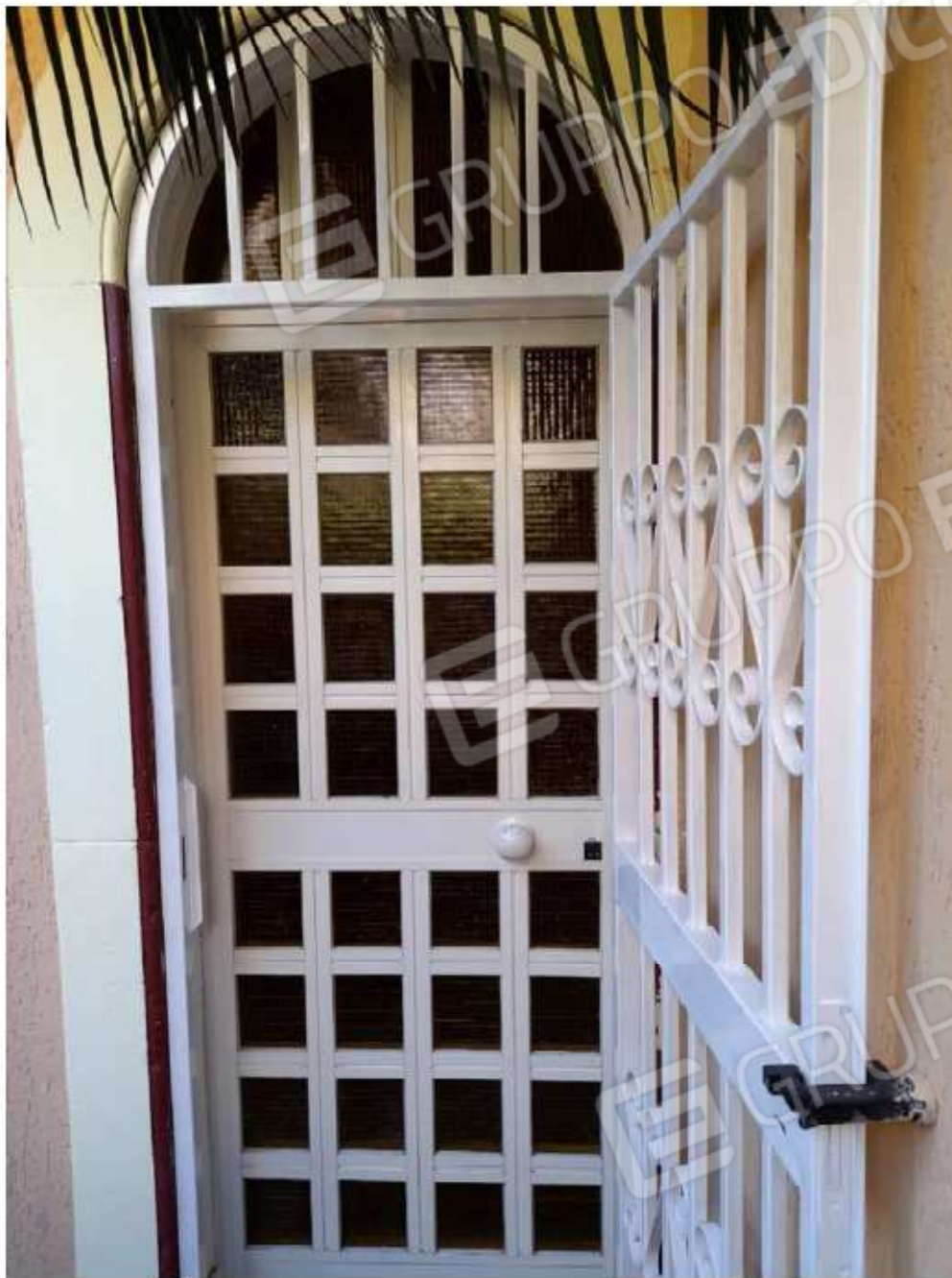
-Foto n.8: Porta di ingresso-
