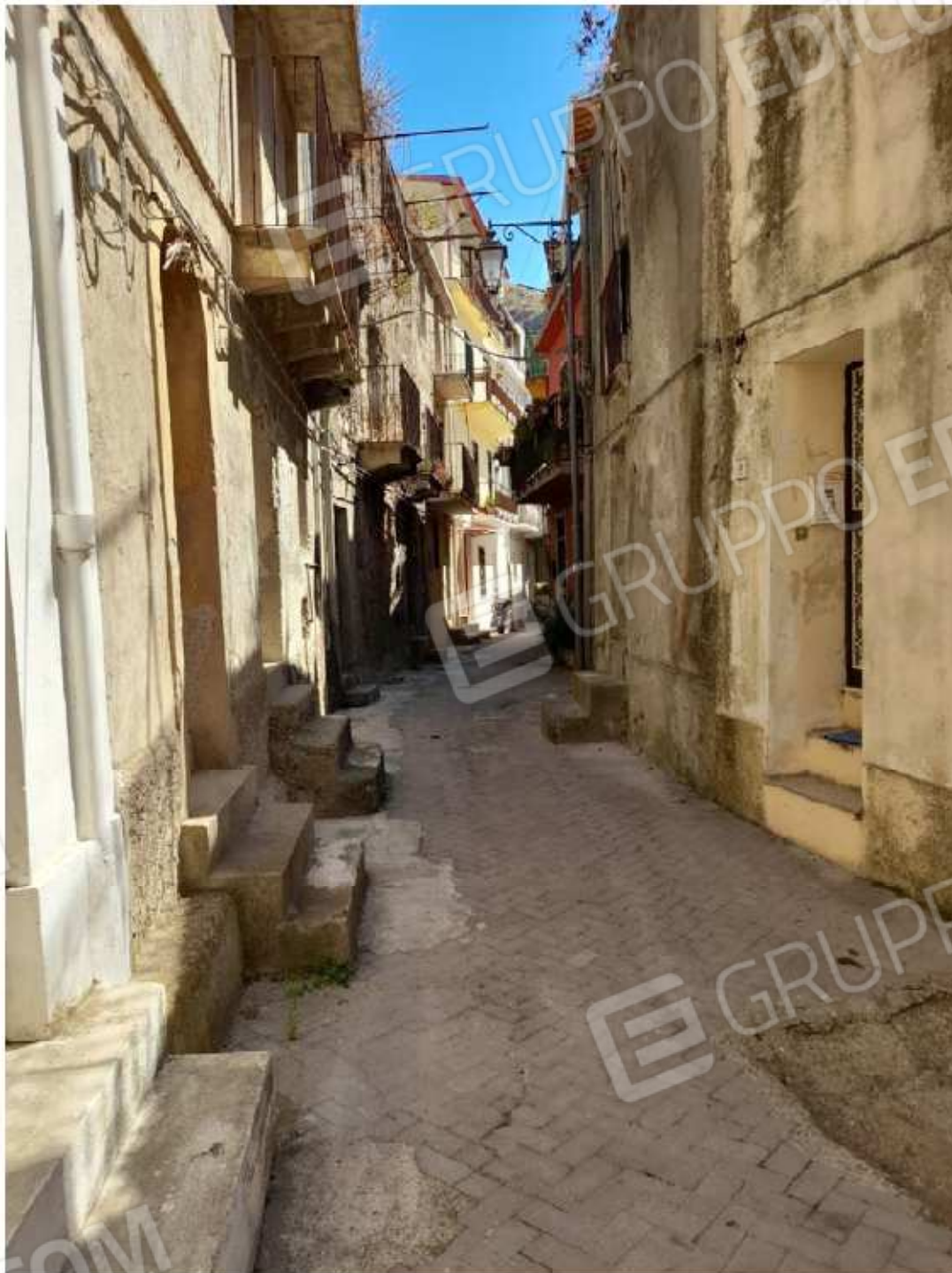
-Foto n.1: Stradina che dalla chiesa madre conduce all'immobile oggetto di causa-
