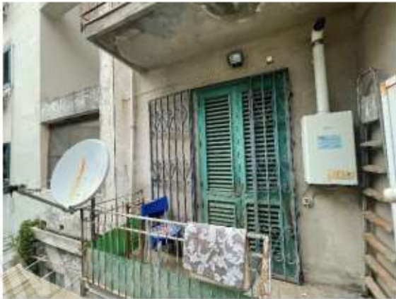
Fig. n. 20 Balcone della camera da letto.
