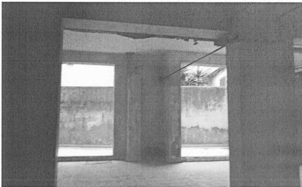
-Foto n.2: Unità al piano terra - garage-
