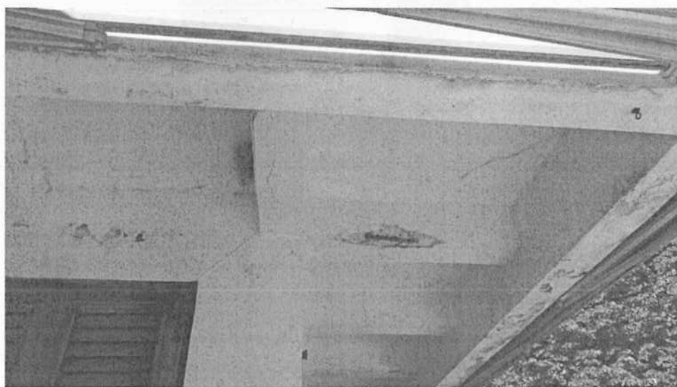
-Foto n.10: Intradosso copertura-
