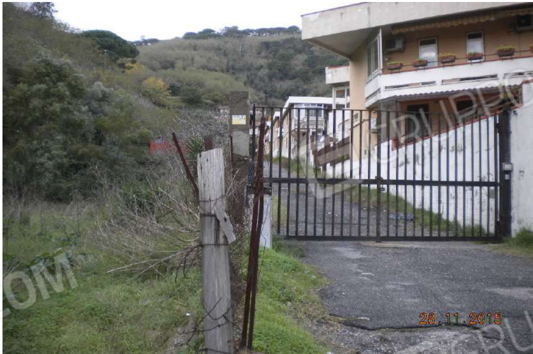
Foto 20 – Cancellò d'accesso ai fondi su strada ex SP1
