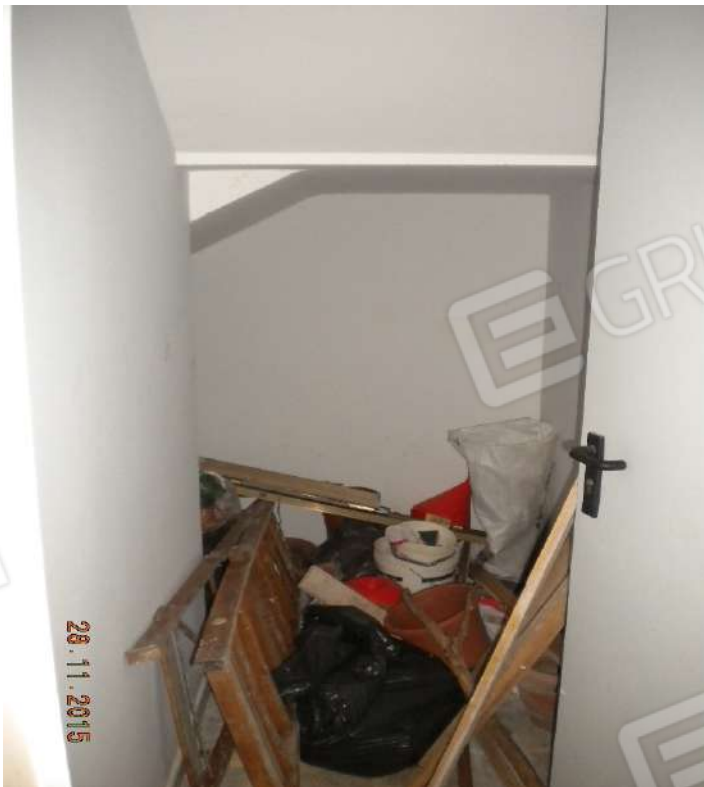
Foto 14 - Locale di Sgombero foglio 62 part. 1570 sub 21
