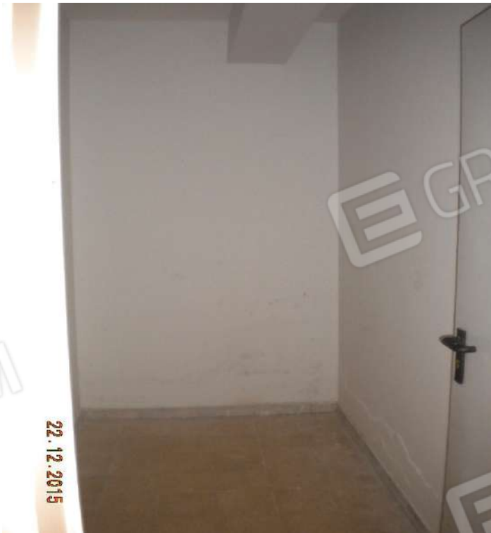
Foto 12 – Locale di Sgombero foglio 62 part. 1570 sub 17
