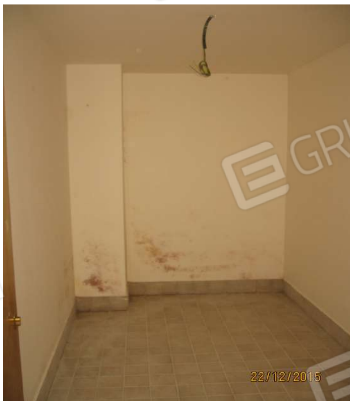
Foto 6 – Locale Deposito foglio 62 part. 1622 sub 6
