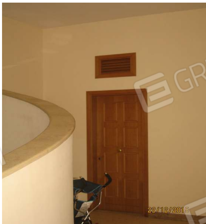
Foto 8 – Locale Deposito foglio 62 part. 1622 sub 16
