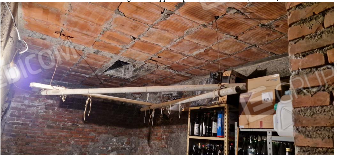
Foto 6: Cantina censita al foglio di mappa 15 particella 564 sub 4 (ex sub 1)..
