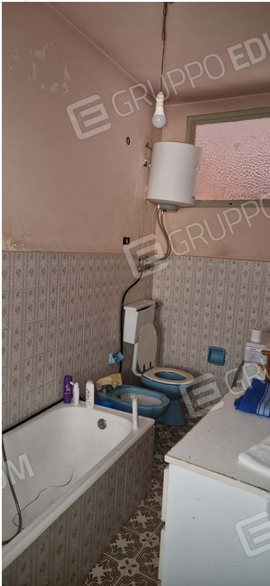
Foto 19: Appartamento censito al foglio di mappa 15 particella 564 sub 5 (ex sub 2 e 3)
