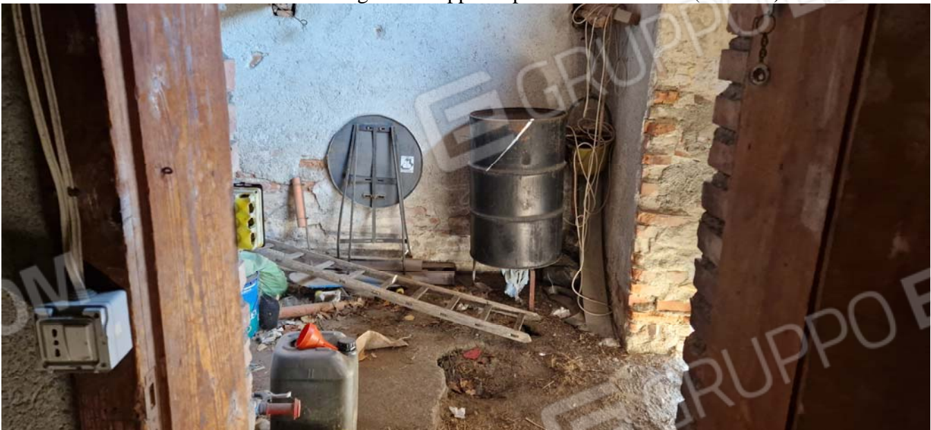
Foto 2: Cantina censita al foglio di mappa 15 particella 564 sub 4 (ex sub 1).
