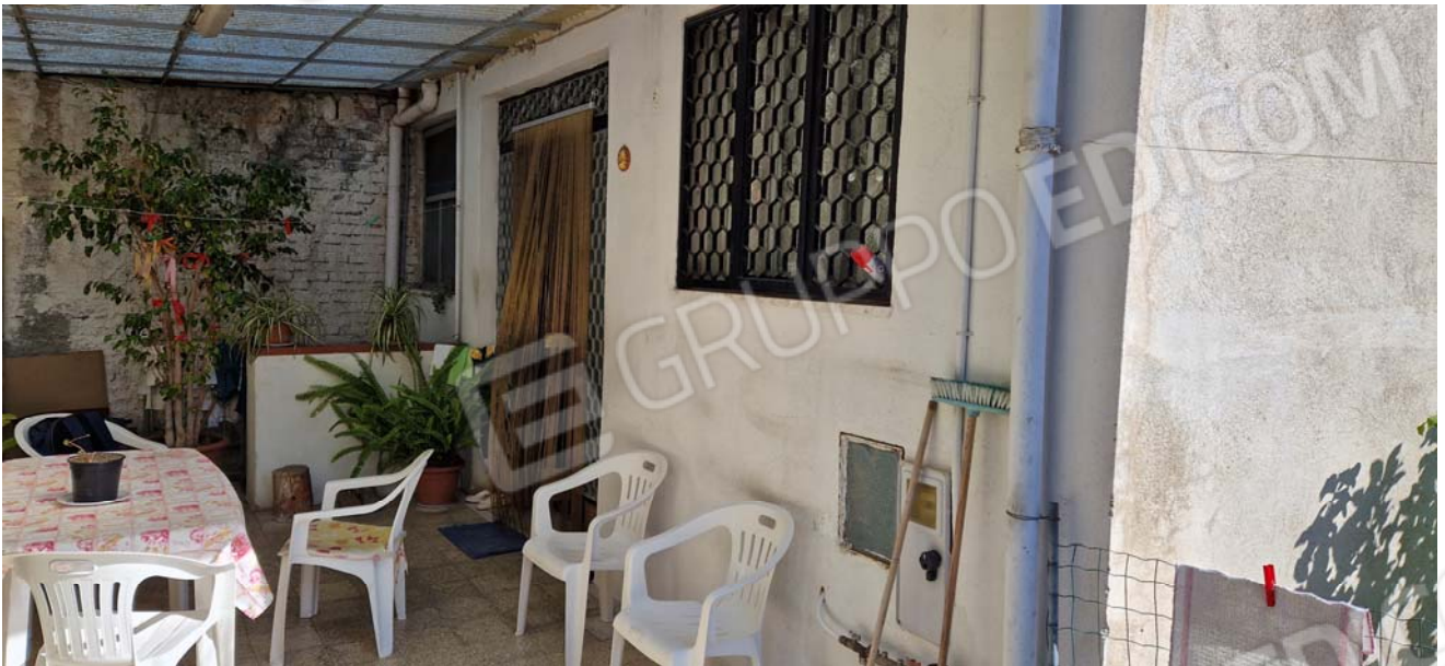
Foto 8: Appartamento censito al foglio di mappa 15 particella 564 sub 5 (ex sub 2 e 3)
