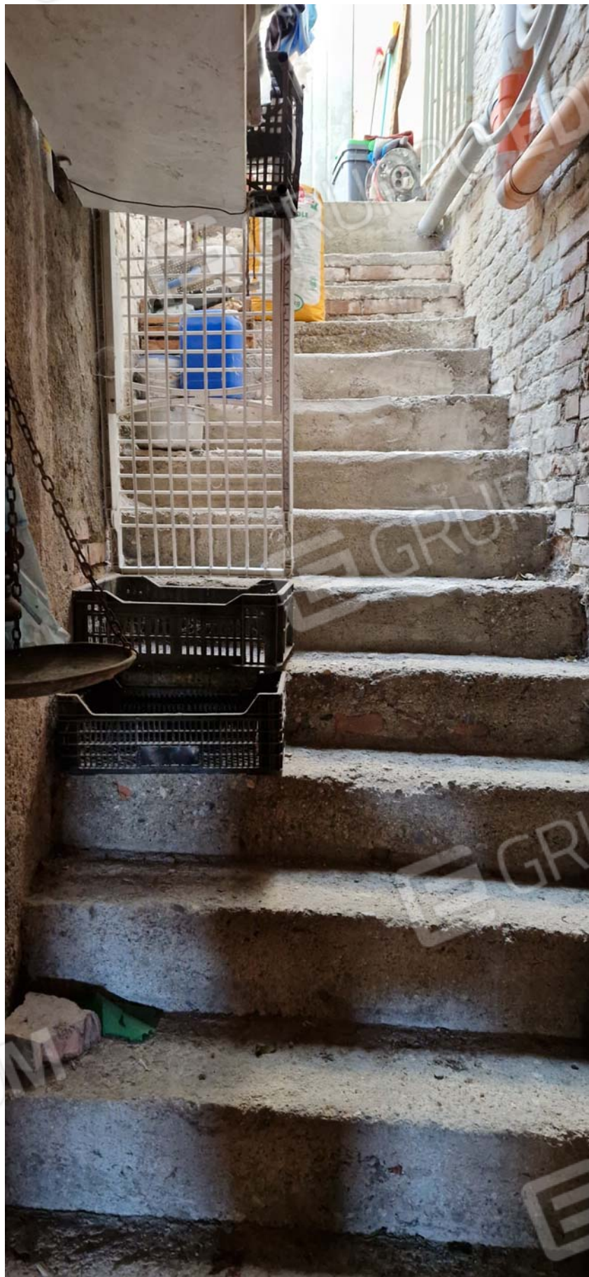
Foto 7: Scala di collegamento tra la cantina censita al foglio di mappa 15 particella 564 sub 4 (ex sub 1). Ed il terreno particella 564.
