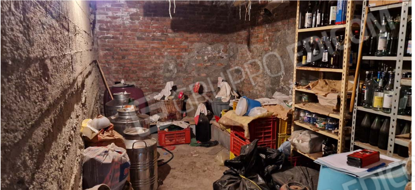
Foto 4: Cantina censita al foglio di mappa 15 particella 564 sub 4 (ex sub 1).
