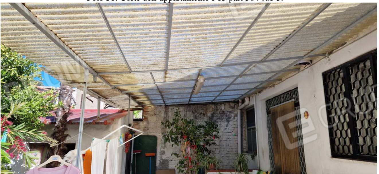
Foto 32: Tettoia realizzata nella zona ingresso da demolire.
