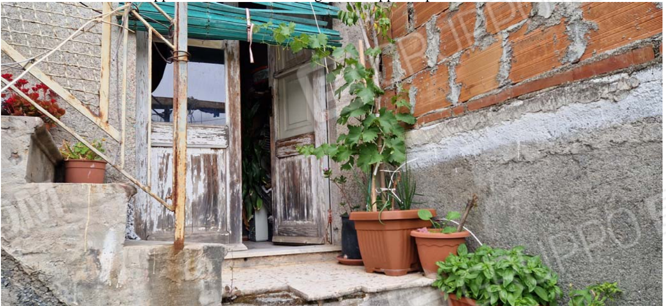
Foto 16: Appartamento censito al foglio di mappa 15 particella 484 sub 1
