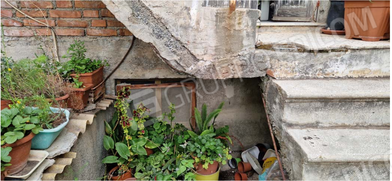
Foto 15: Appartamento censito al foglio di mappa 15 particella 484 sub 1.
