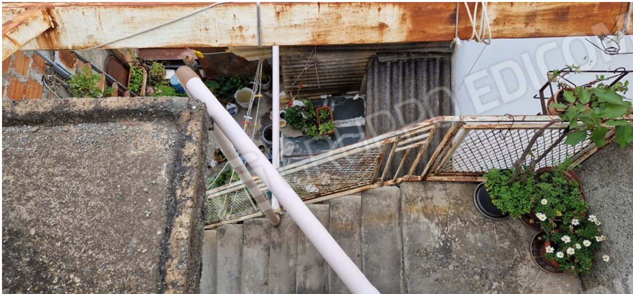
Foto 19: Appartamento censito al foglio di mappa 15 particella 484 sub 1
