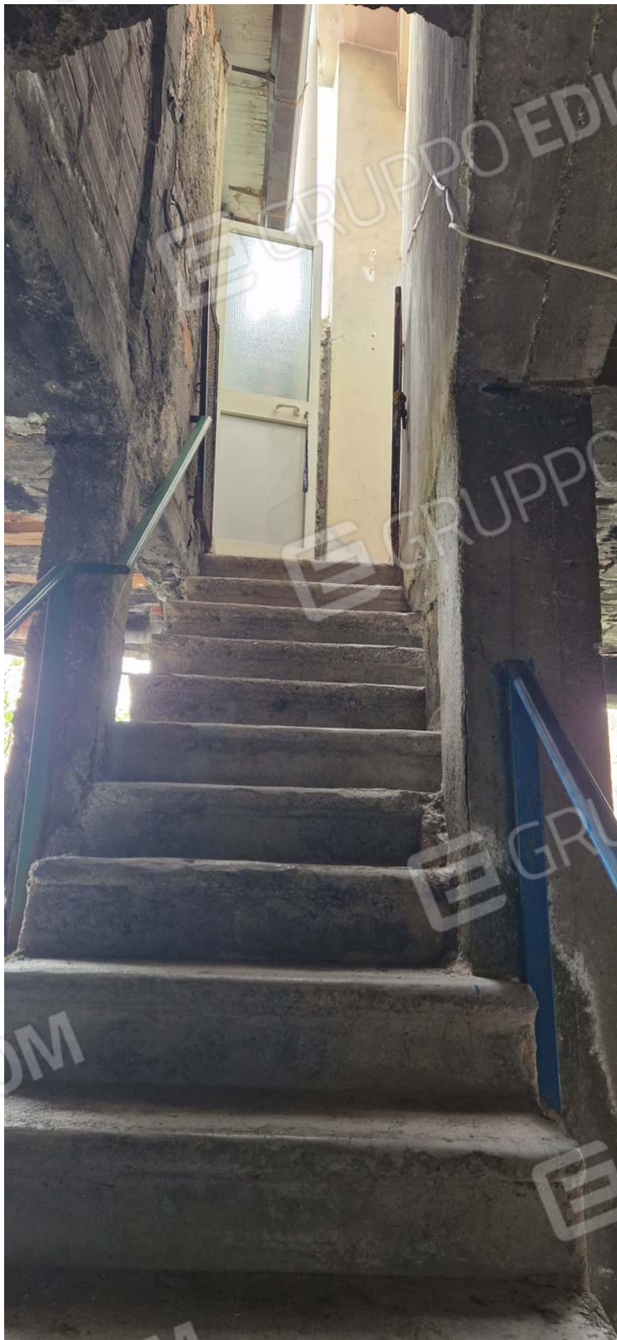
Foto 5: Appartamento censito al foglio di mappa 15 particella 484 sub 1.
