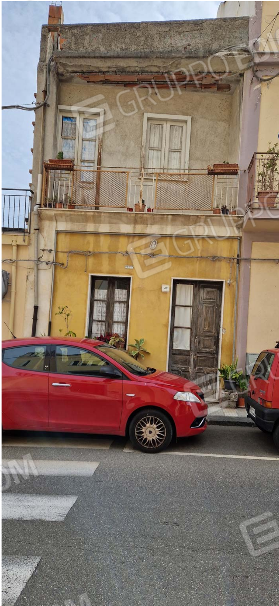
Foto 1: Appartamento censito al foglio di mappa 15 particella 484 sub 1.
