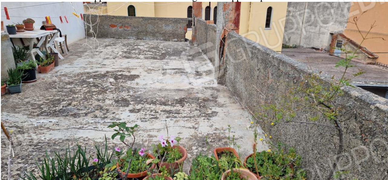
Foto 20: Appartamento censito al foglio di mappa 15 particella 484 sub 1
