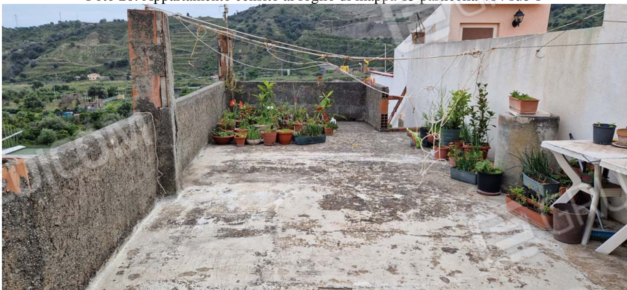
Foto 21: Appartamento censito al foglio di mappa 15 particella 484 sub 1
