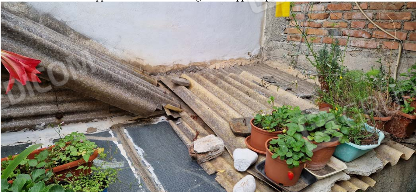
Foto 14: Appartamento censito al foglio di mappa 15 particella 484 sub 1.
