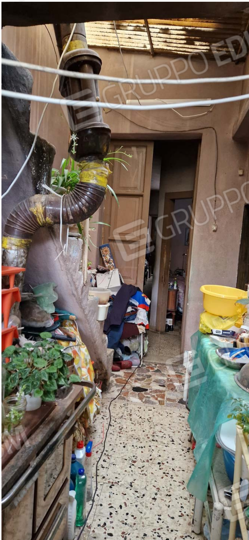
Foto 11: Appartamento censito al foglio di mappa 15 particella 484 sub 1.
