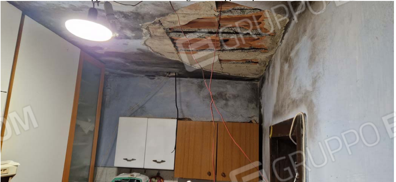
Foto 13: Appartamento censito al foglio di mappa 15 particella 484 sub 1.
