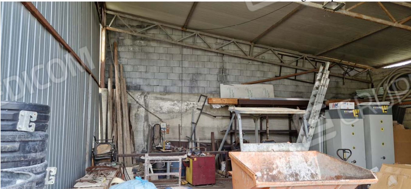
Foto 9: Fabbricato realizzato abusivamente sul terreno Furci Siculo Foglio 12 part. 237.
