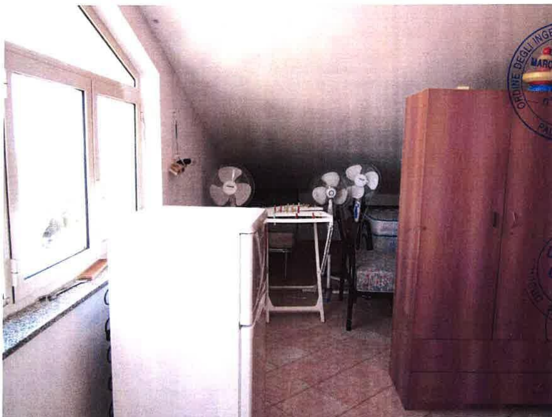
Foto 24: la porzione del sottotetto, in fondo a destra del vano unico indicato catastalmente come "... locale deposito ...";
