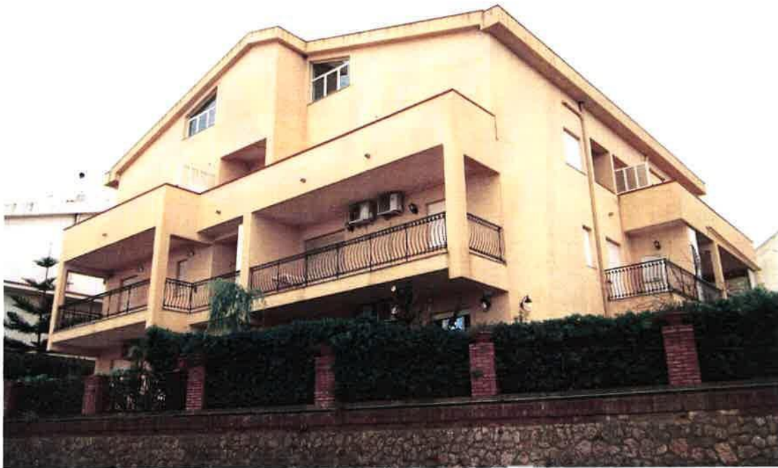
Foto 3: Vista, dalla statale, dell'edificio in cui al secondo e terzo piano insiste l'appartamento identificato catastalmente, nel foglio 7 di Messina, dalla particella 776 sub. 12
