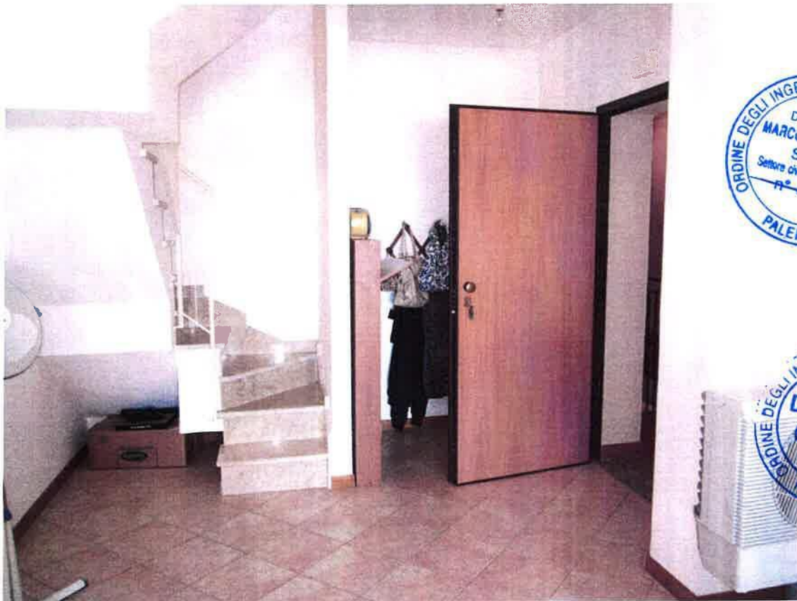
Foto 20: la partenza della scala interna che collega il secondo piano al sottotetto (locale agibile)
