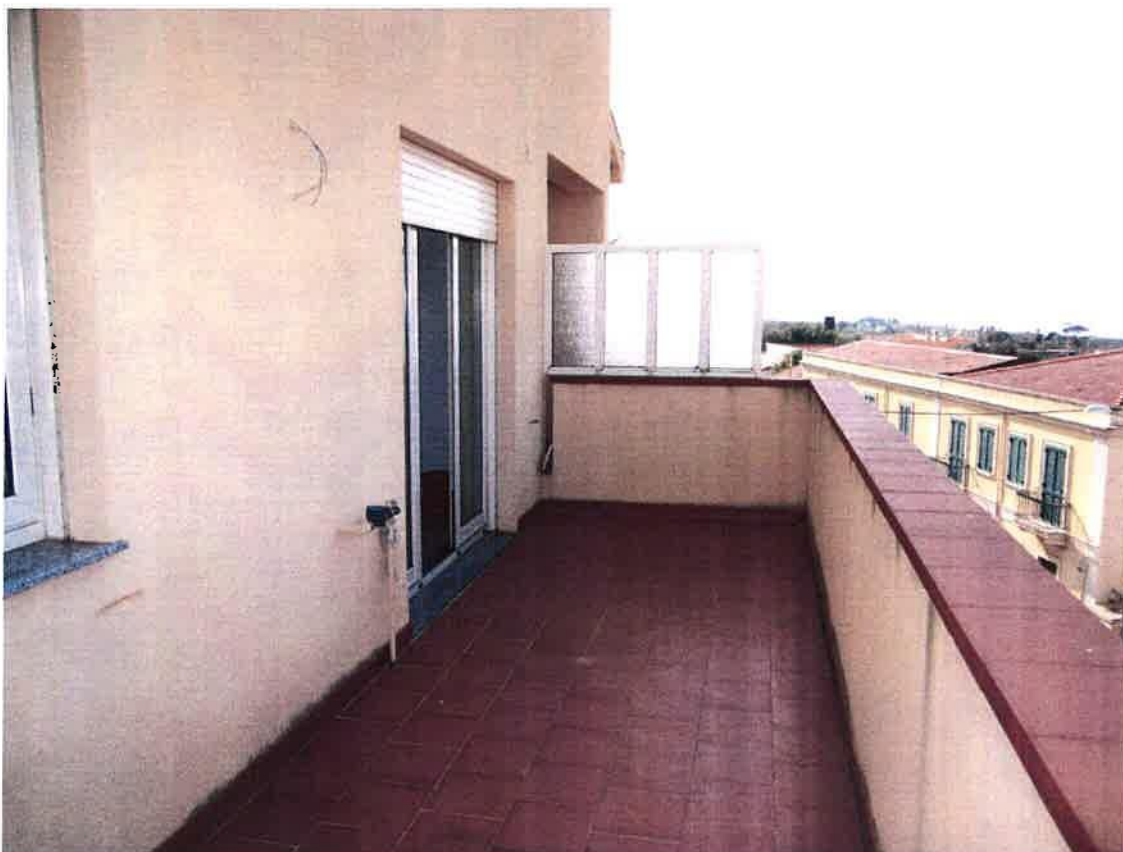
Foto 13: inquadratura, dal punto di vista opposto, del balcone con affaccio verso la strada statale
