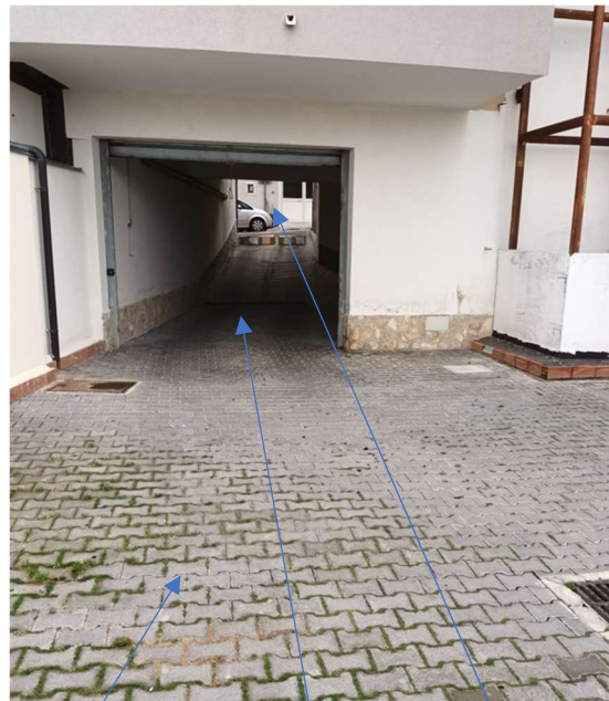
Area scoperta- rampa di accesso - via pubblica
