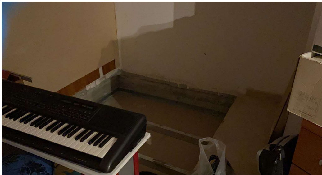
Alcuni particolari dell'immobile di cui al sub. 11
