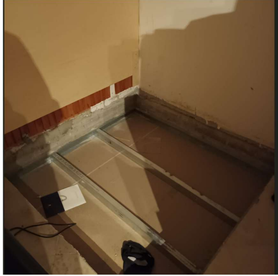
Foro su solaio
