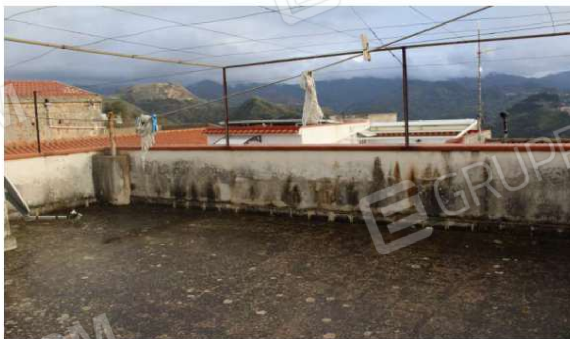
Lastrico Solare Piano Secondo
