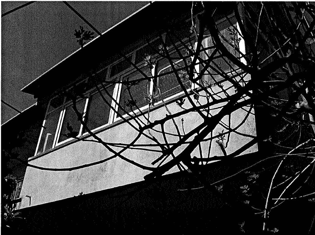
Foto n.1 = per documentare la parte di prospetto secondario e la parziale chiusura con struttura precarie della porzione di balcone di maggiore ampiezza
