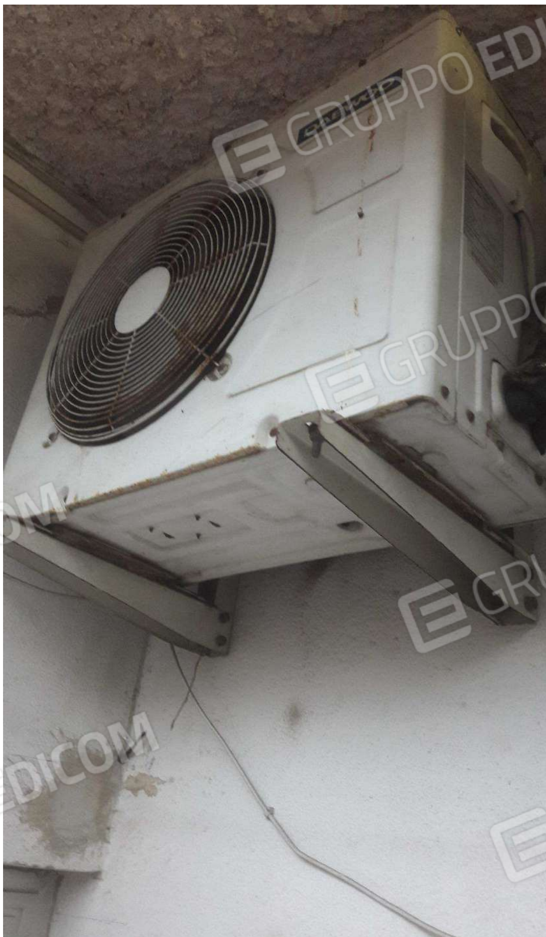
FOTO N.42 PARETE NUOVO BALCONE CON CLIMATIZZATORE CUCINA
