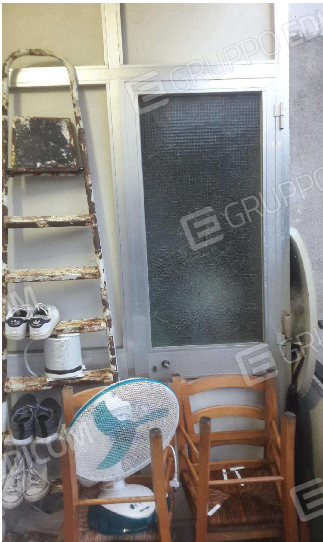
FOTO N.40 AREA NUOVO BALCONE ED INFISSO RIPOSTIGLIO
