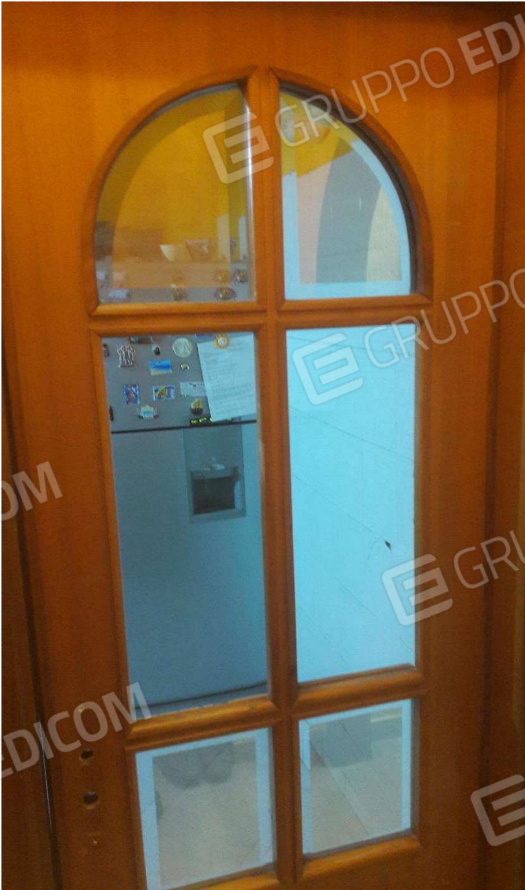
FOTO N.7 INFISSO INTERNO CUCINA
