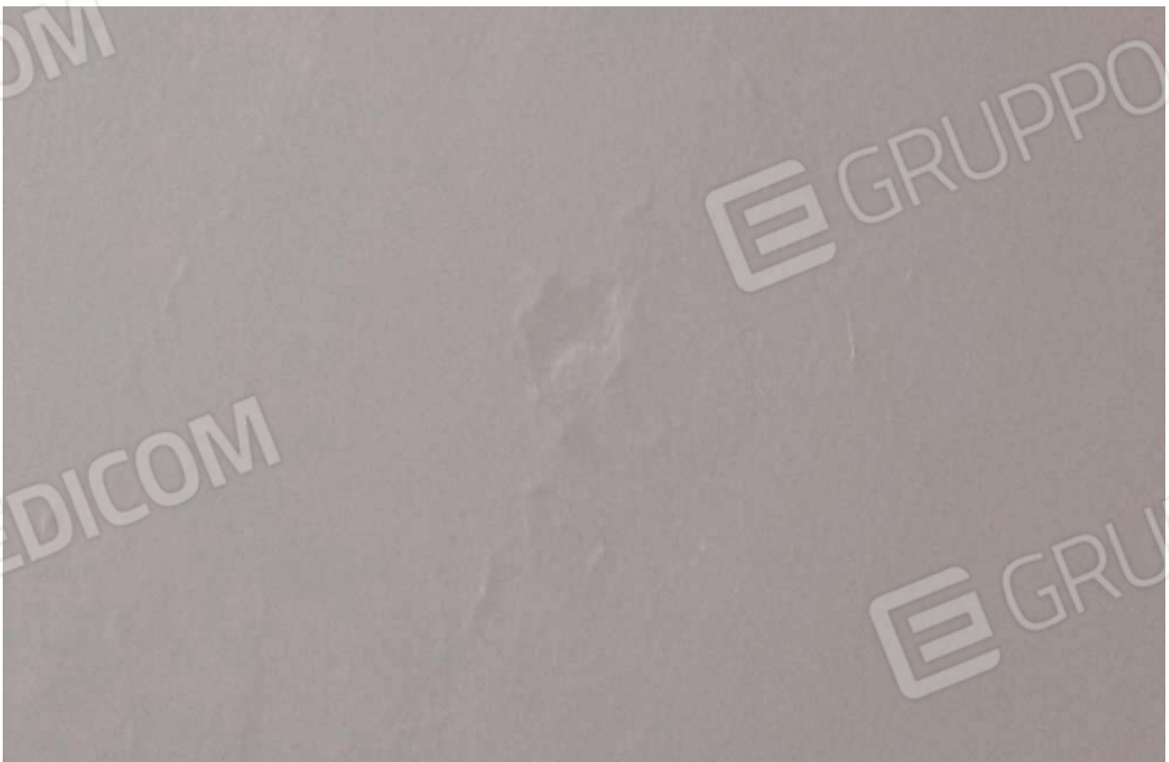
FOTO N.22 TINTEGGIATURA SOFFITTO CON INTONACO AMMALORATO
