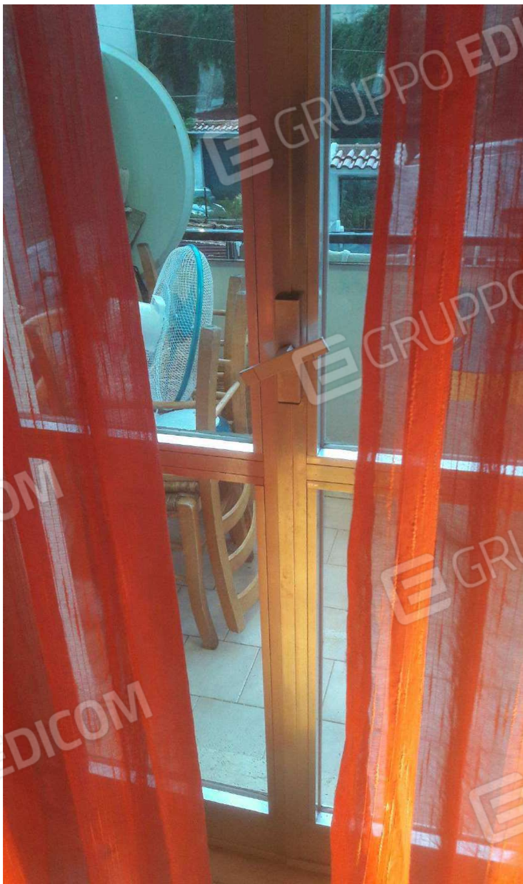
FOTO N.38 INFISSO ESTERNO SOGGIORNO
