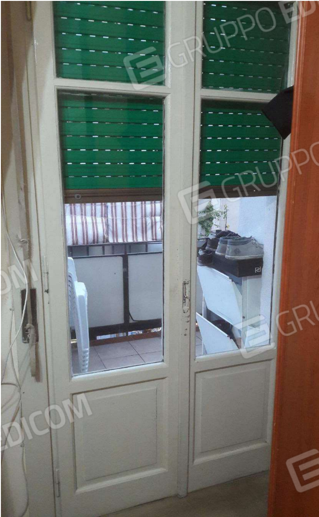
FOTO N.29 INFISSO ESTERNO CAMERA DA LETTO MATRIMONIALE
