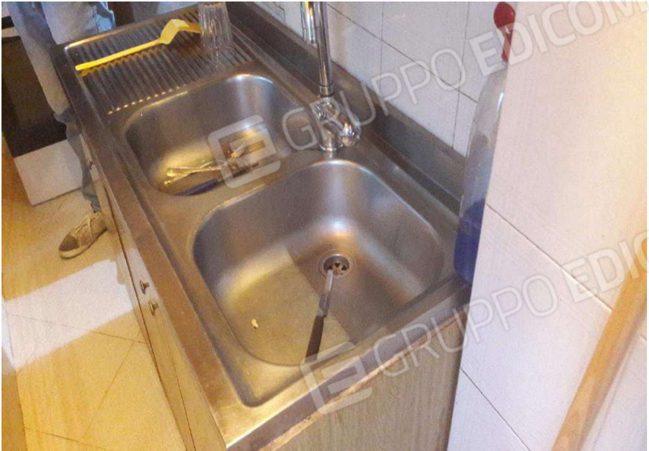
FOTO N.12 LAVELLO POSIZIONATO SULL'ORIGINARIA AREA BALCONE
