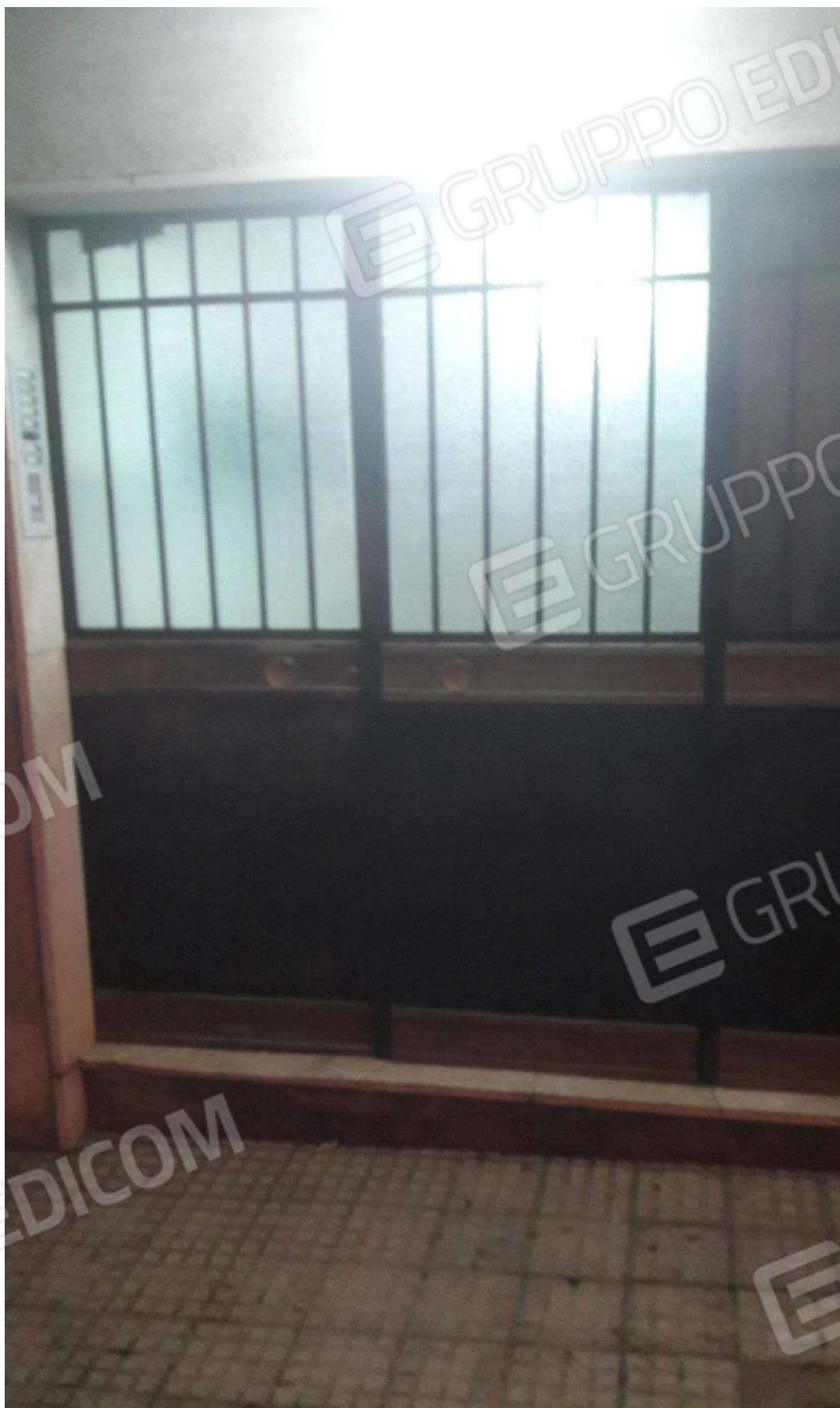
FOTO N.1 PORTONE CONDOMINIALE SULLA PUBBLICA VIA
