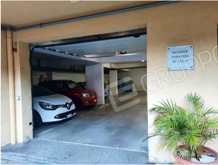
foto n°3 - ingresso posto auto
