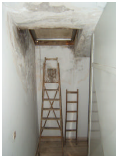
Foto n. 3: Lotto 1 – Pianerottolo scala al piano sottotetto
