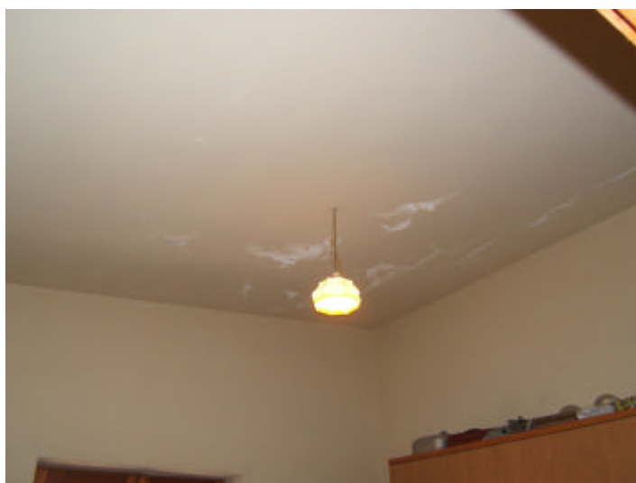
Foto n. 14: Lotto 2 – Tracce d'umido e lesioni nella camera con affaccio su via Napoli
