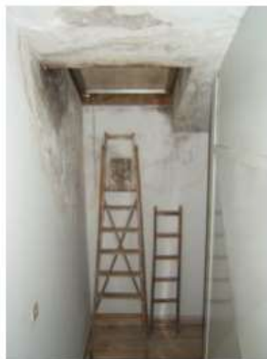
Foto n. 3: Lotto 1 – Pianerottolo scala al piano sottotetto
