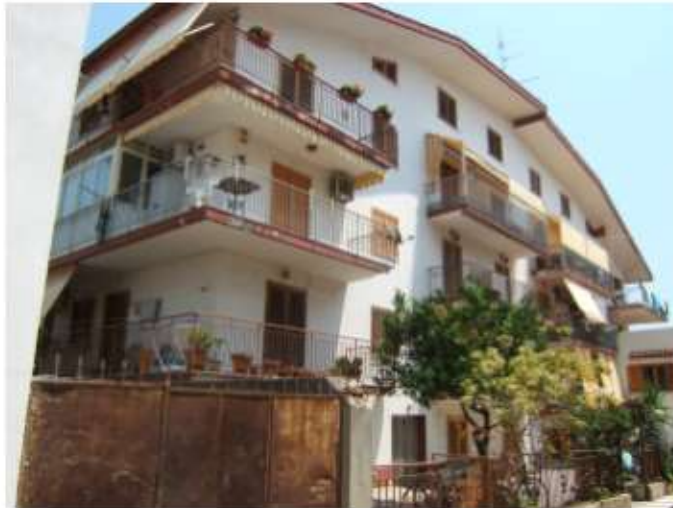
Foto n. 1: Lotto 1 – Prospetto dell'edificio su via Napoli
