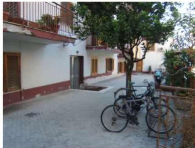
Foto n. 2: Lotto 1 – Cortile condominiale su via Napoli
