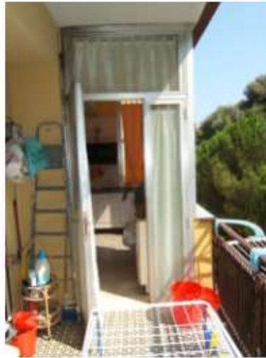
Foto n. 25: Lotto 3 – Balcone prospettante sul cortile interno
