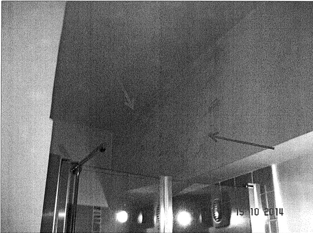
Foto n.15 : Diffuse macchie da condensa sulla trave presente nel wc n.2 sopra il box doccia ;
