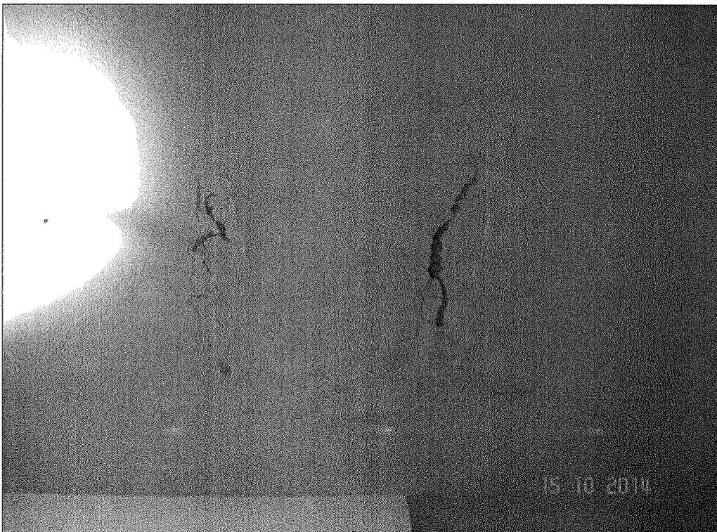
Foto n.16 : Wc n.2- particolare dei danni da infiltrazioni riscontrati ;
