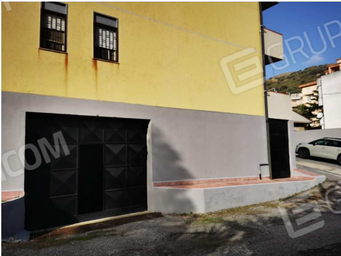
FOTO n. 10 – Portone ingresso deposito
