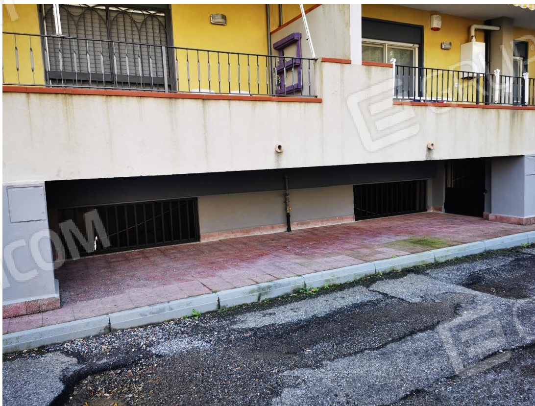
FOTO n. 8 – Prospetto nord- finestre lucifere del magazzino
