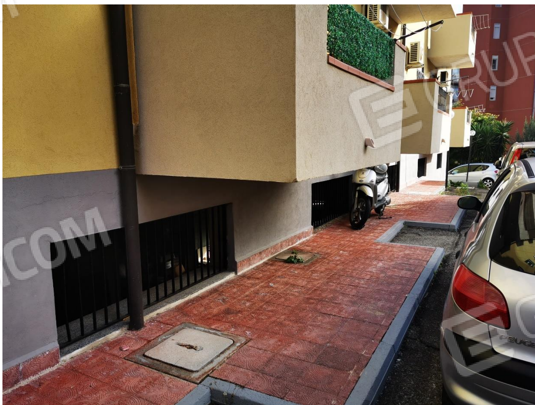
FOTO n. 4 – Lato sud- Finestre lucifere del deposito
