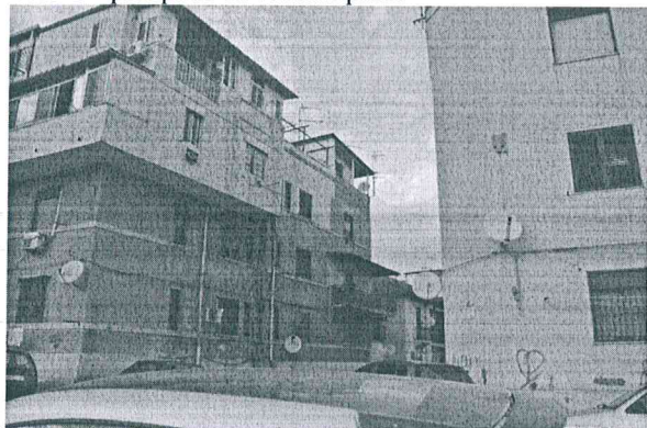
Foto 1 "prospetto su via Sempione"
