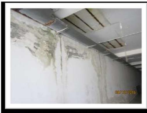
Al piano interrato si rilevano le tracce di umido sulle pareti e il soffitto ammalorato
