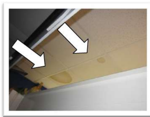
Umido nella pannellatura del controsoffitto sostituiti a metà gennaio
