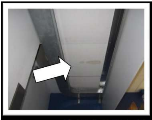
Umido nella pannellatura del controsoffitto sostituiti a metà gennaio
