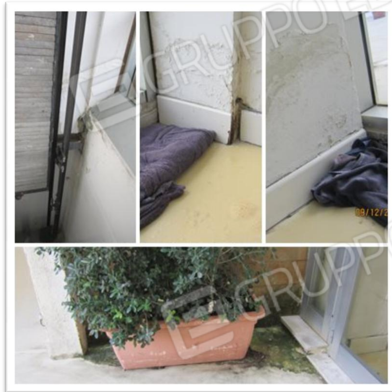
Foto n. 43 da sn in alto: Vano ascensore - Ufficio reception - in basso Portico sul retro hall
