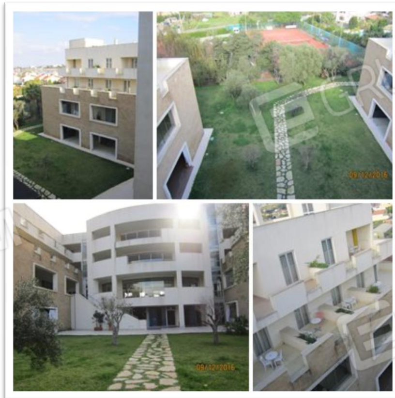
Foto n. 42 da sn: corpo rettangolare ad est, percorso per la piscina, retro hall, corpo ovest
