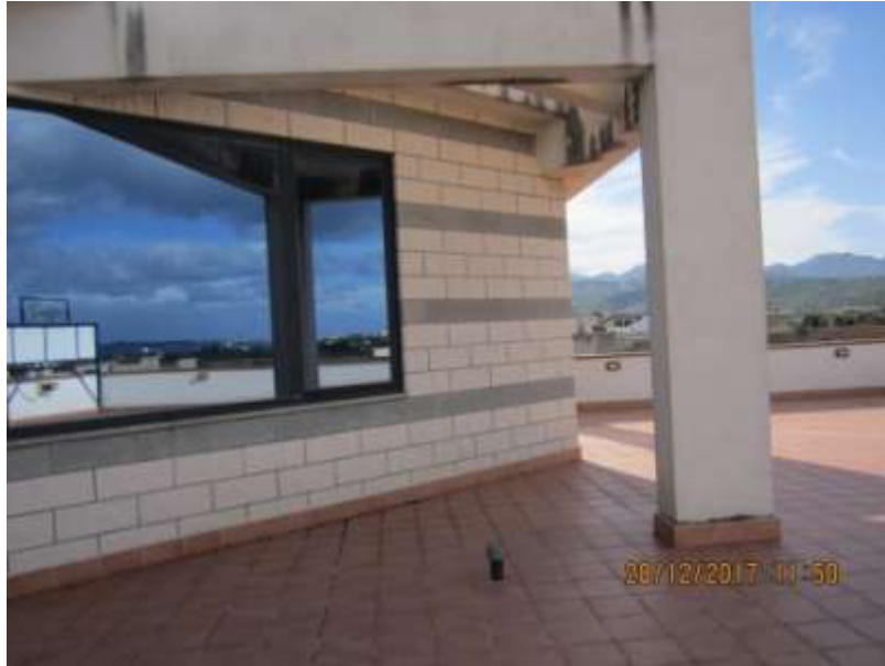
Foto n° 27 Terrazza nel corpo ad ovest
