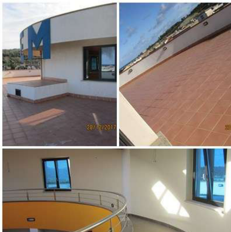
Foto n° 35 Terrazza e pianerottolo al piano secondo
