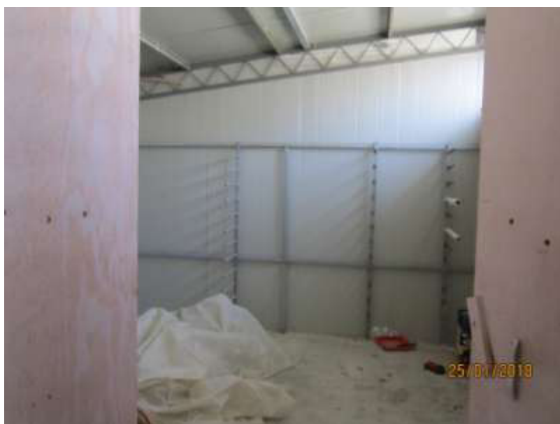
Foto n° 38 Locale asciugatura limitrofo
