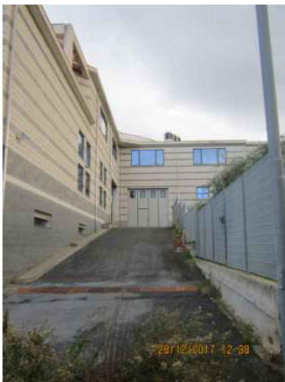
Foto n° 5 Vista sul retro corpi est (di fronte) ed ovest (a sinistra)
