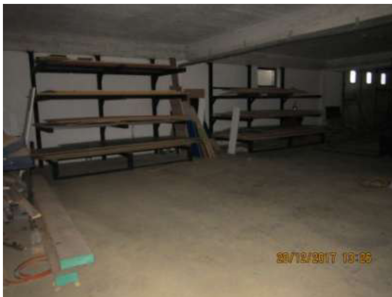
Foto n° 6 Seminterrato corpo sud
