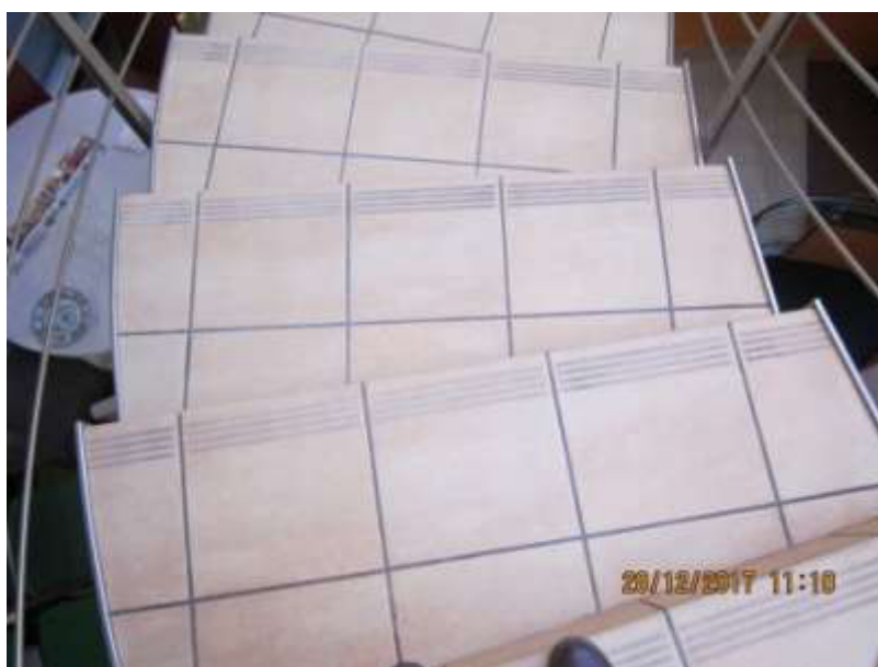
Foto n° 32 La pavimentazione dei gradini
