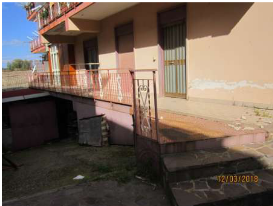
Foto n° 5 Prospetto lato sud, balcone e vetrate
