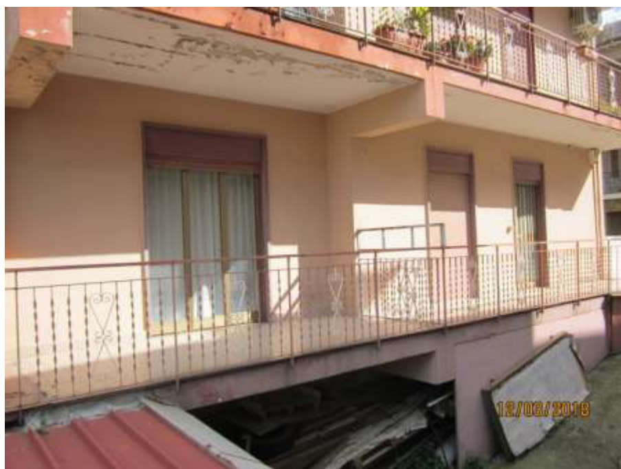
Foto n° 4 Prospetto lato sud, balcone e vetrate
