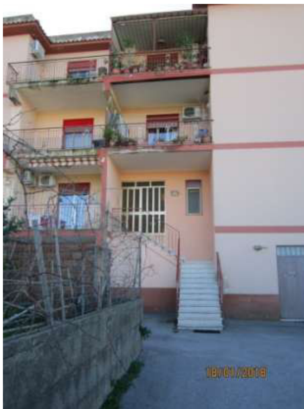
Foto n° 3 Portone d'entrata dalla strada condominiale, vista dell'immobile lato nord
