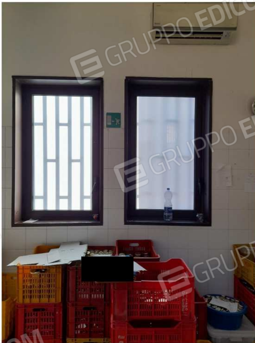
-Foto n.25: Locale "laboratorio": dettaglio infissi -
