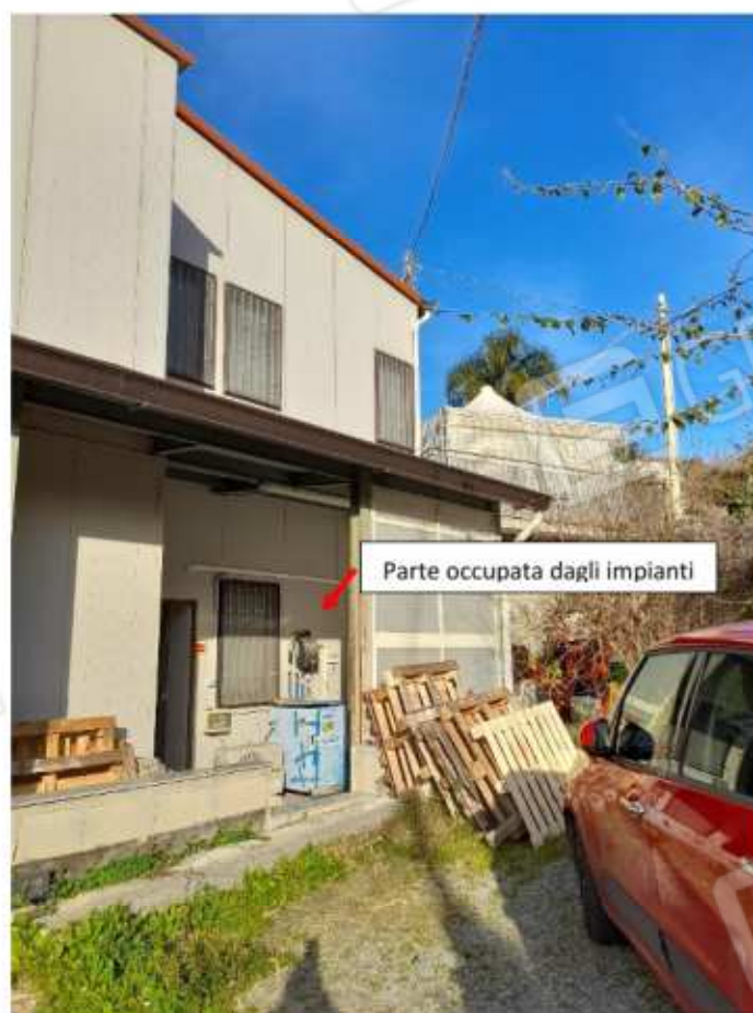
-Foto n.4: Prospetto lato via Maiorani -
