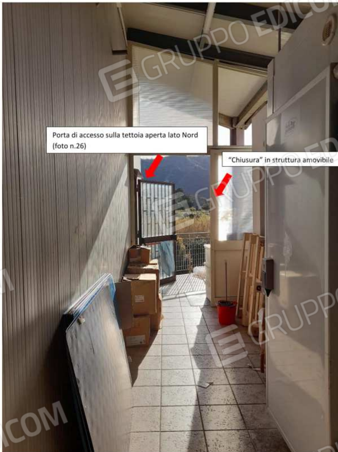
-Foto n.30: Chiusura in struttura amovibile tettoia lato Nord -
