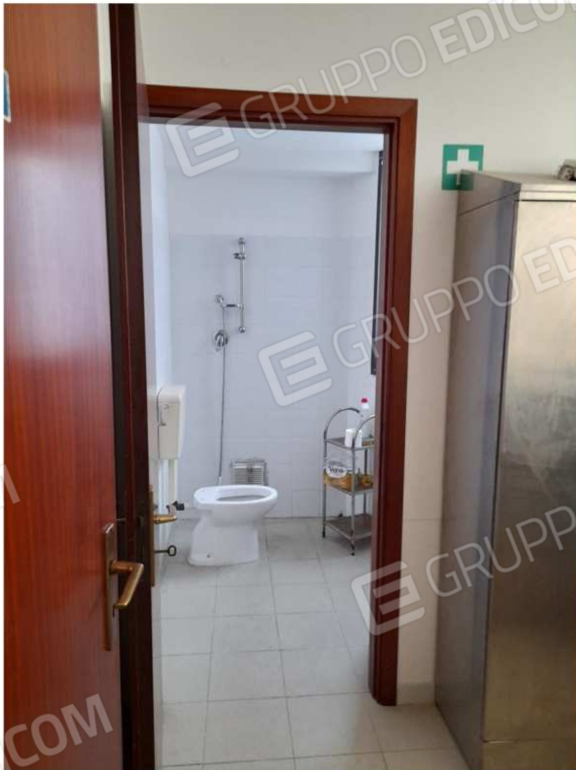
-Foto n.16: Vano wc donne -
