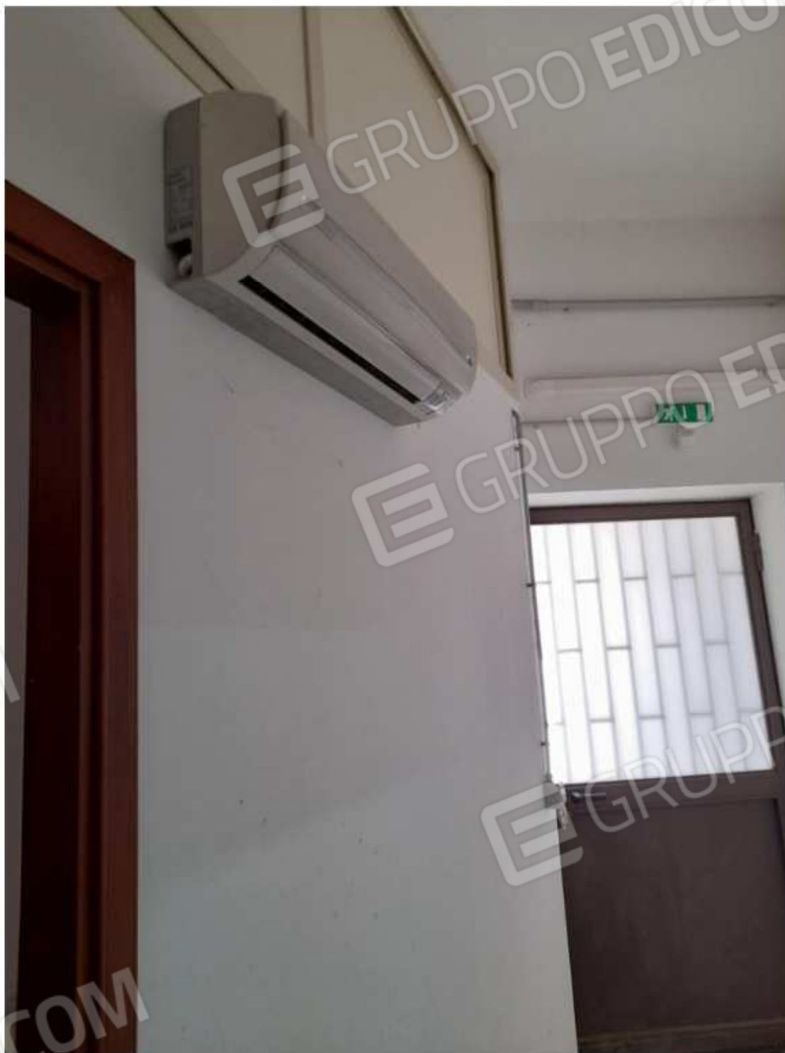
-Foto n.10: Ingresso via Maiorani-
