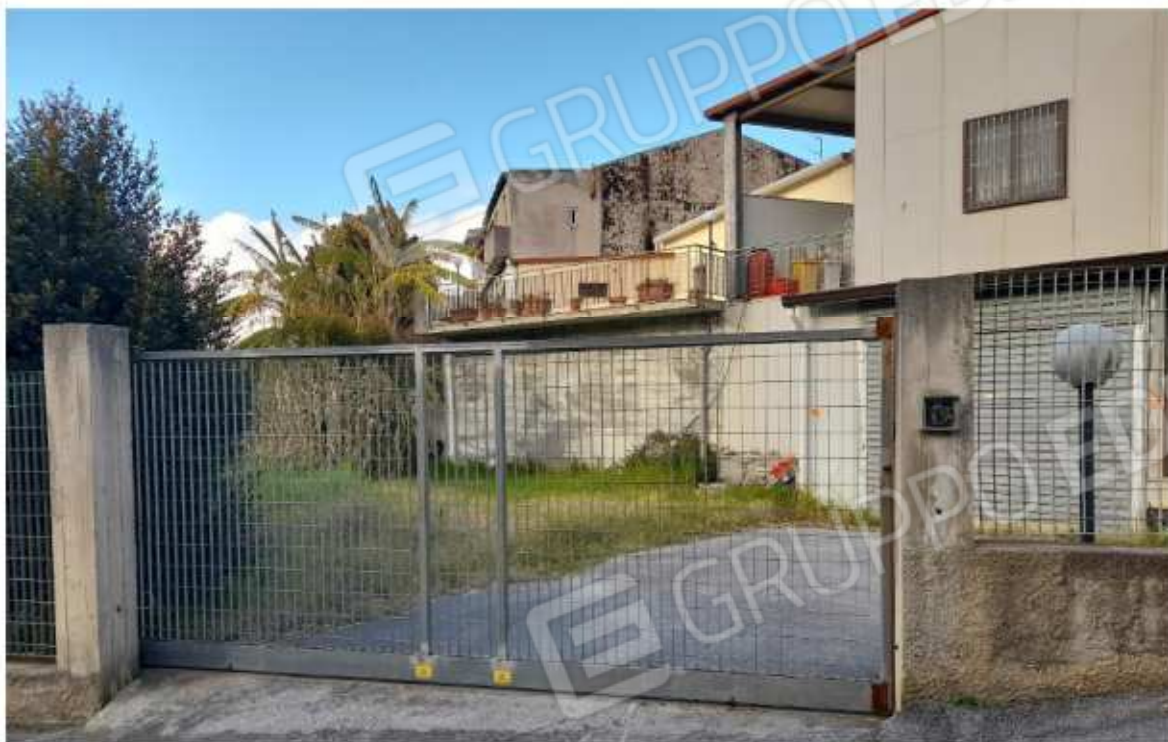
-Foto n.1: Ingresso via Maiorani-
