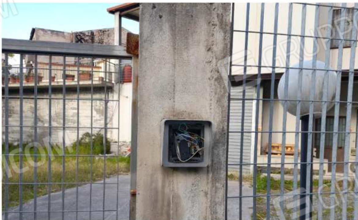
-Foto n.2: Impianto citofonico in disuso-
