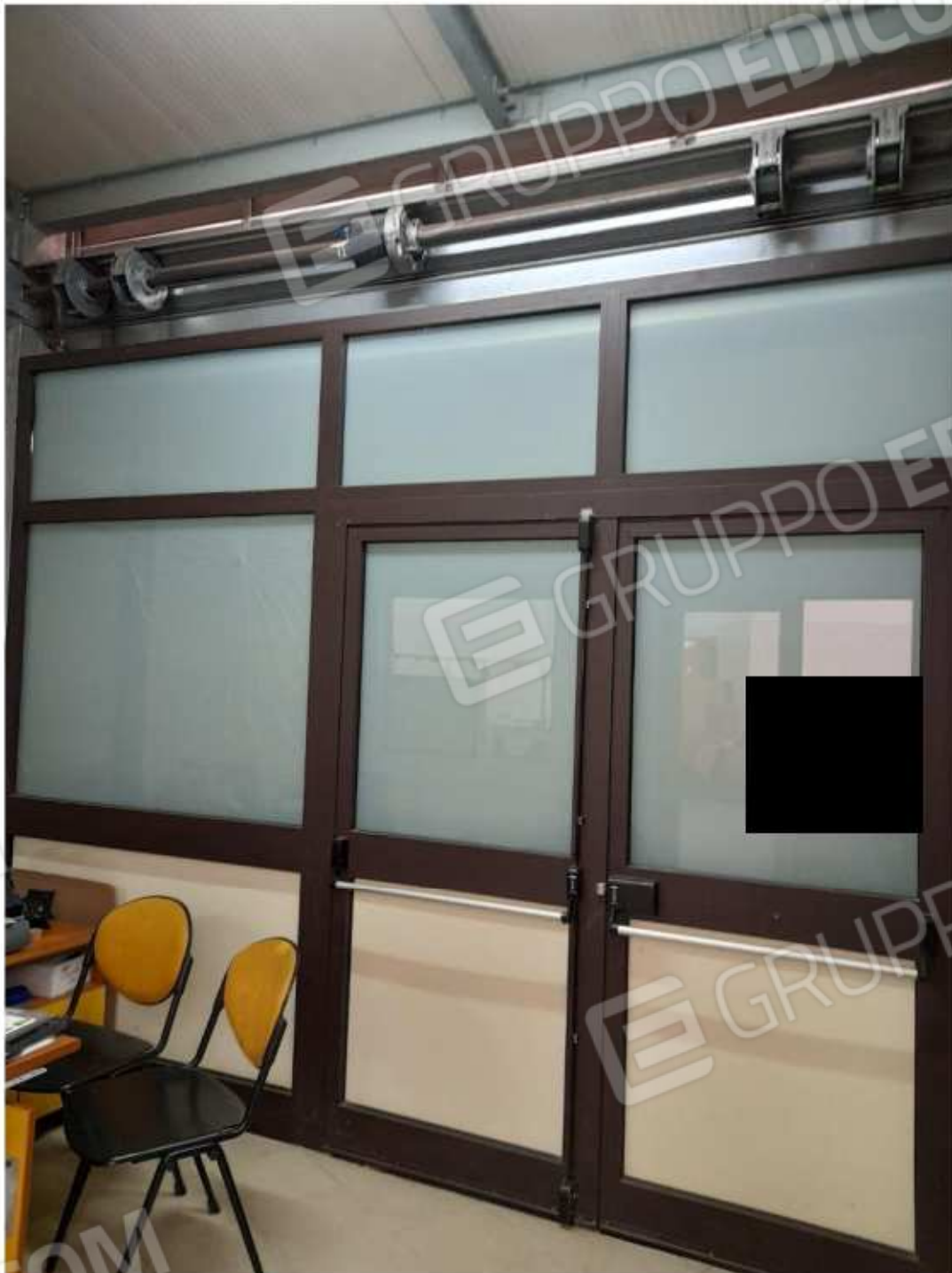
-Foto n.14: Ingresso al "vano ufficio" ricavato sotto la tettoia-
