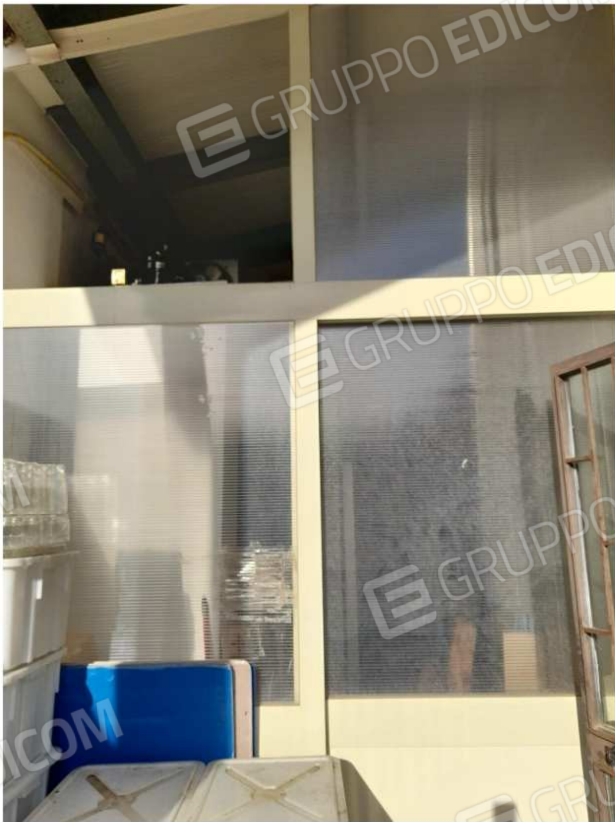
-Foto n.31: Dettaglio chiusura in struttura amovibile tettoia lato Nord -
