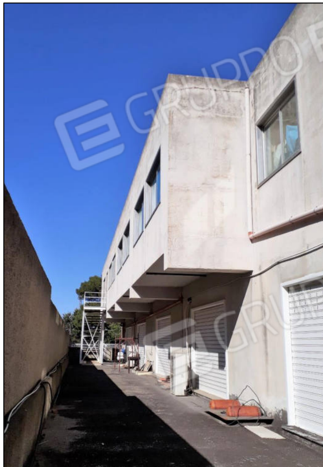
FOTO 08: corte esclusiva lato ovest.
