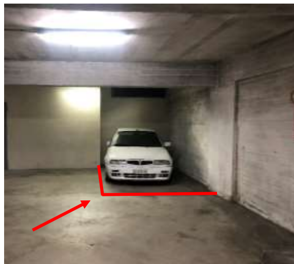
Figura 34 – Posto auto al piano seminterrato
