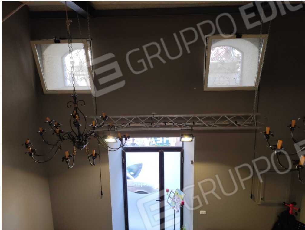
Foto 27– Veduta della doppia altezza lato ingresso.
