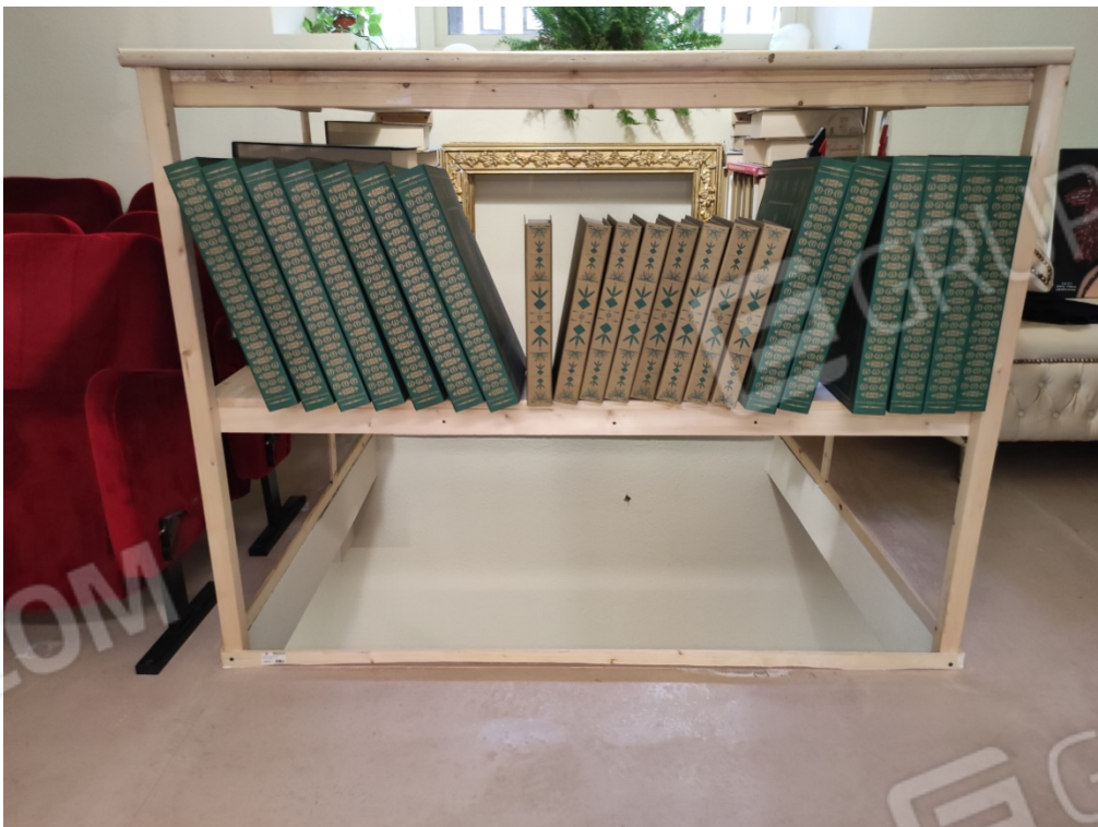
Foto 33 e 34 – Particolare della doppia altezza coincidente con il sottostante deposito del piano terra.
