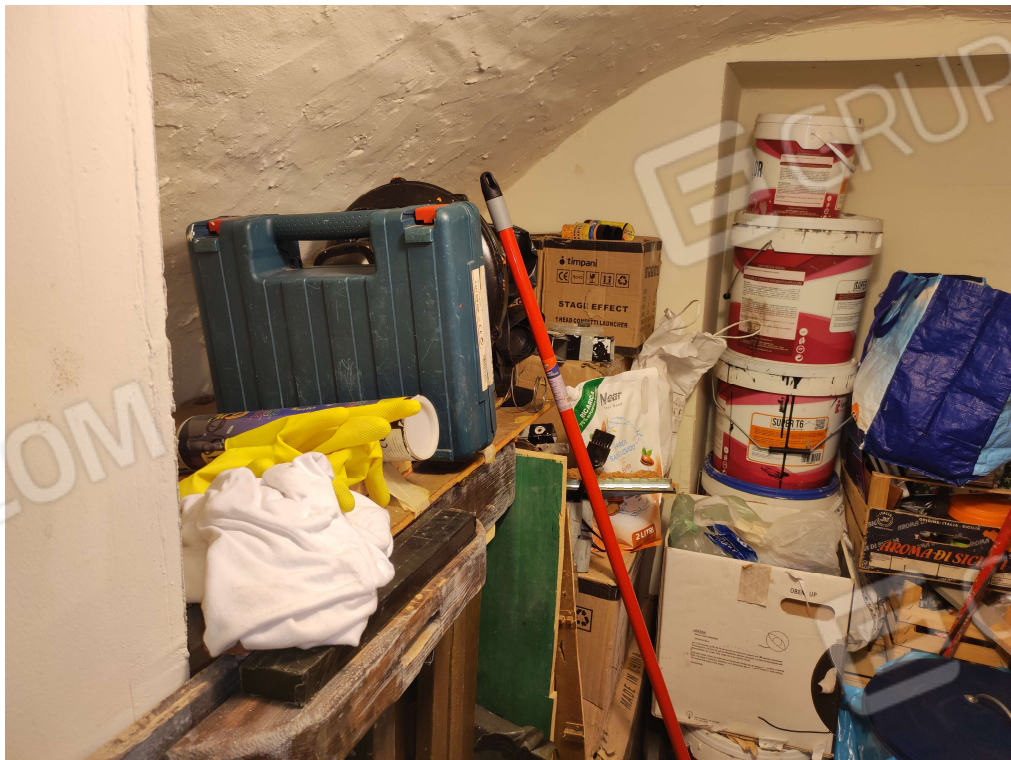
Foto 17 e 18 – Interno del ripostiglio e particolare del soffitto.
