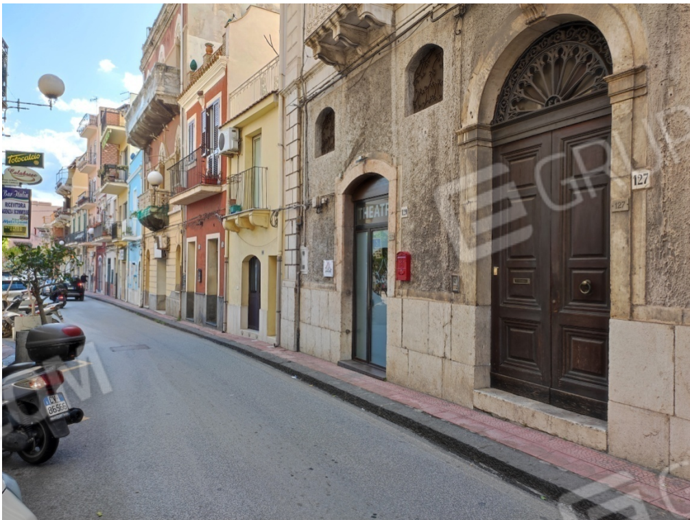
Foto 3 e 4 – Via Umberto I in direzione Messina-Catania. Sotto, a destra, l'immobile pignorato al n. 129.
