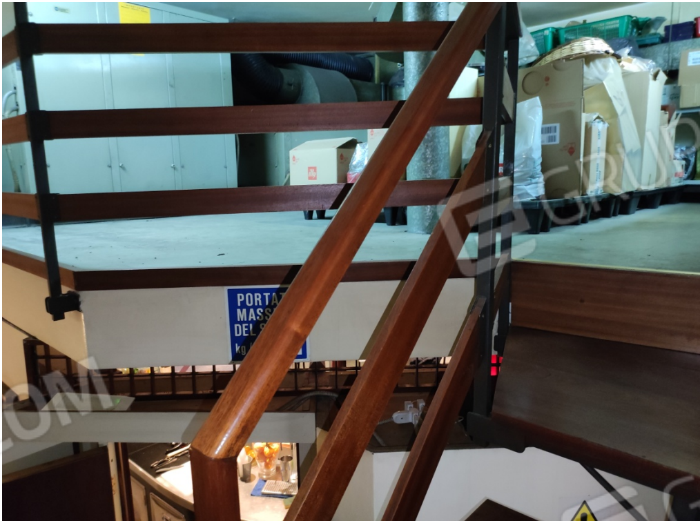
Foto 35 e 36 – Ingresso al locale tecnico.
