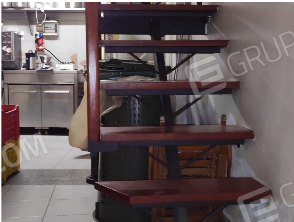
Foto 32 – Particolare del corpo scala in legno e ferro.
