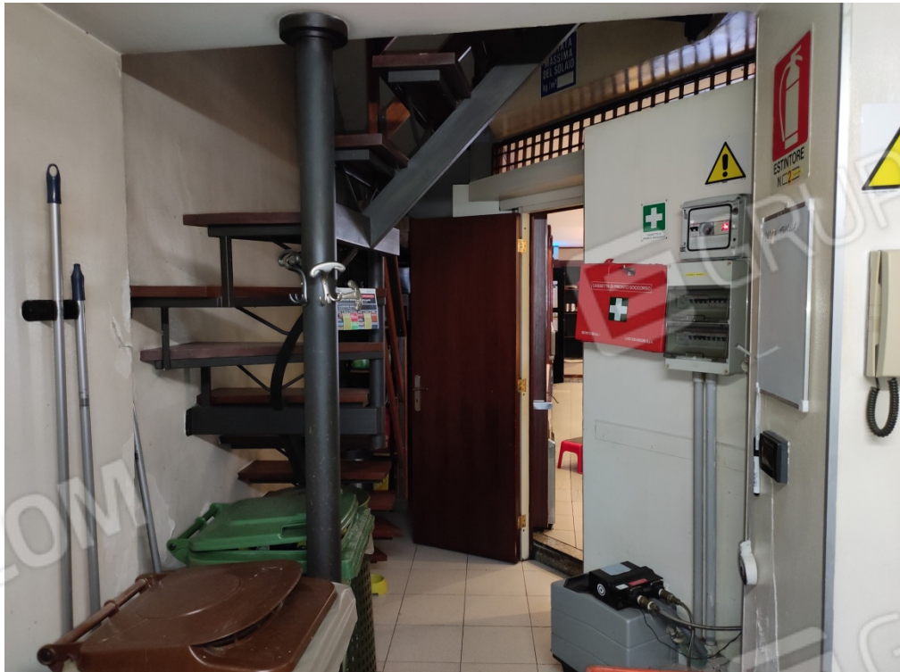
Foto 27 e 28 – Accesso al laboratorio dal retro banco e parziale veduta del corpo scala per accedere locale tecnico (sala macchia-condizionatore).
