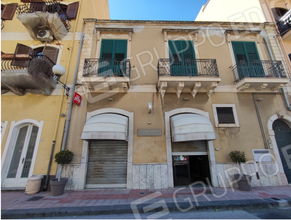
Figura 1 – Veduta delle due botteghe e del fabbricato a due elevazioni fuori terra prospiciente Via Umberto I.
