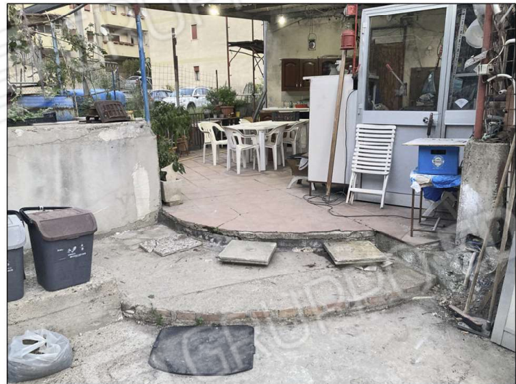
prospetto lato ovest e platea di pertinenza cementificata
