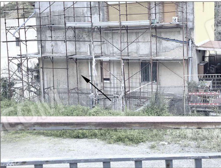
prospetto lato nord
